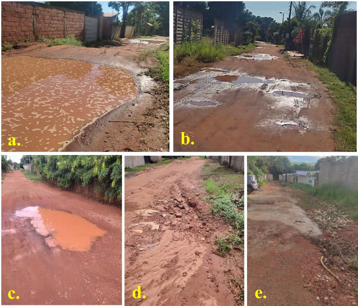
Figura 4: Formação de poças d'água (4a; 4b; 4c), sulcos (4d) e acúmulo de sedimentos (4e).
