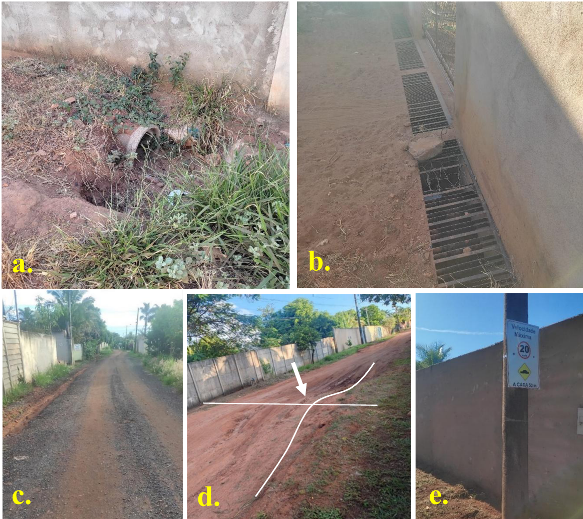
Figura 5: Estruturas de drenagem implementadas como medidas paliativas (5a; 5b), Ponto de compactação e colocação de brita sobre a via (5c), quebra-molas que auxiliam na redução da velocidade de escoamento na via (5d), sinalização dos quebra-molas (5e).
