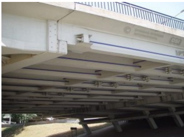
Figura 2 – Viaduto com reforço de cordoalha
