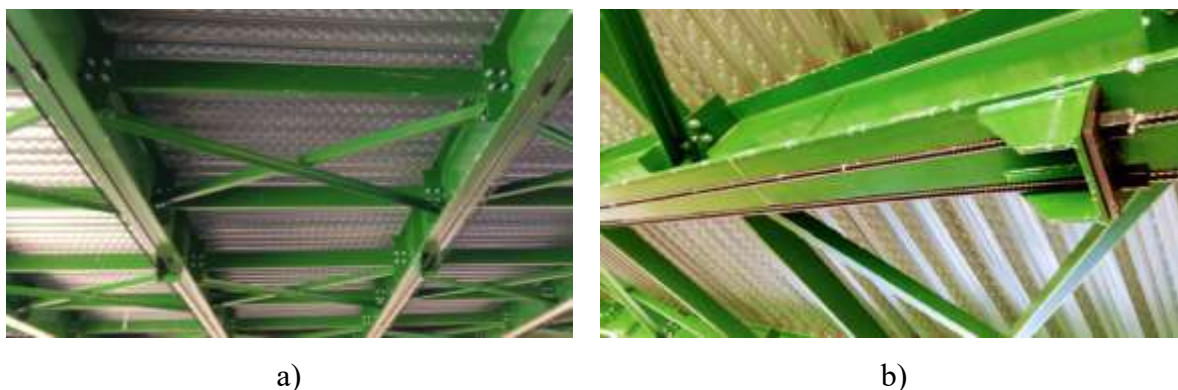
Figura 1.2 - Estrutura em viga mista de aço e concreto protendida da Ponte sobre o córrego Campestre em Lins/SP
