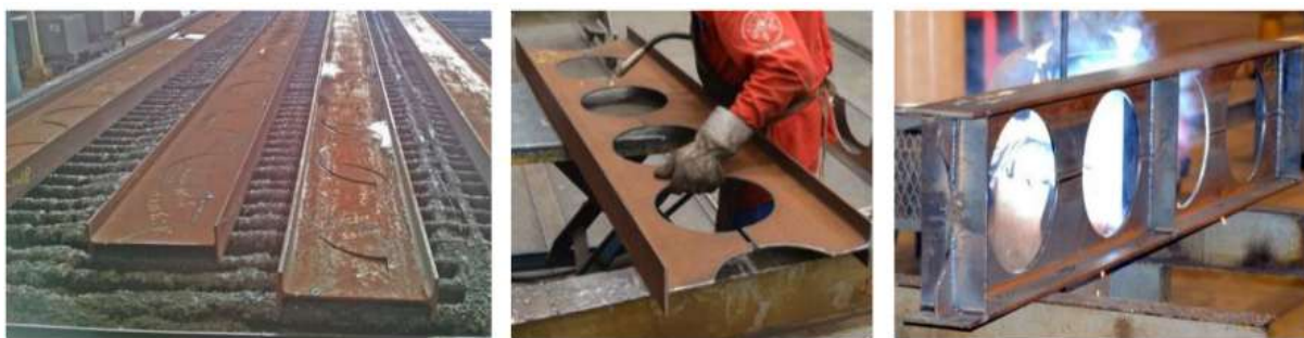
Figura 1.1 - Processo fabricação de vigas celulares de aço
