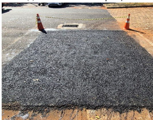
(c) Trecho 1 – após a aplicação e compactação
