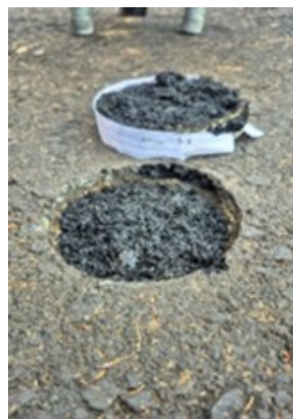
Na mistura asfáltica nova
