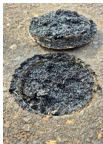
Na mistura asfáltica nova
