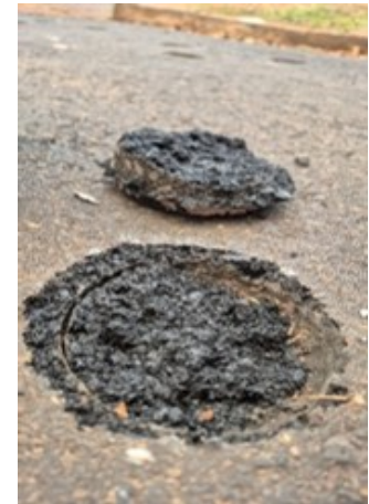
Na mistura asfáltica nova
