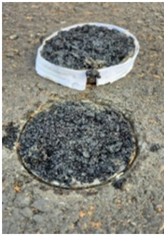
Na mistura asfáltica nova
