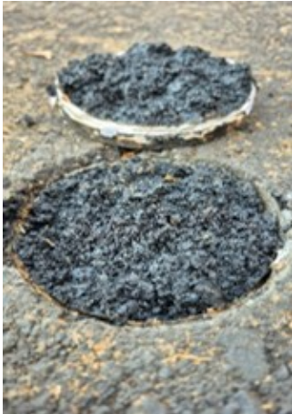
Na mistura asfáltica nova
