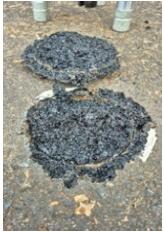
Na mistura asfáltica nova
