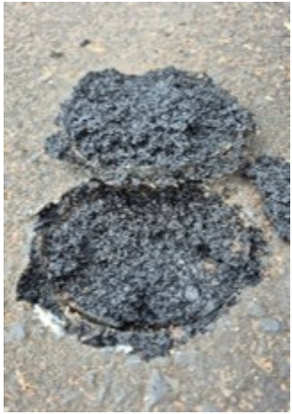
Na mistura asfáltica nova
