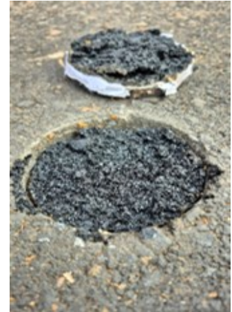
Na mistura asfáltica nova
