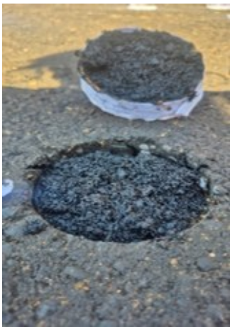
Na mistura asfáltica nova
