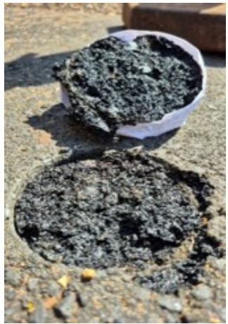
Na mistura asfáltica nova
