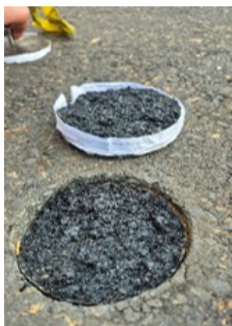
Na mistura asfáltica nova
