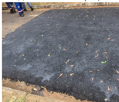
(d) Trecho 2 – após a aplicação e compactação
