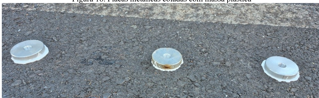
Figura 16. Placas metálicas coladas com massa plástica
