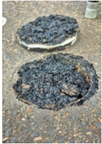
Na mistura asfáltica nova
