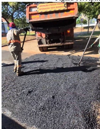
(a) Trecho 1 – durante a aplicação
