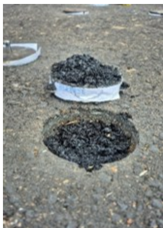
Na mistura asfáltica nova
