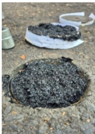
Na mistura asfáltica nova
