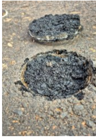
Na mistura asfáltica nova
