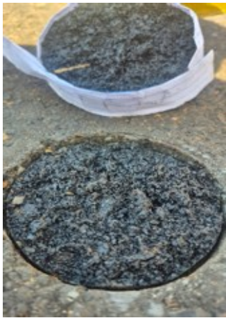
Na mistura asfáltica nova
