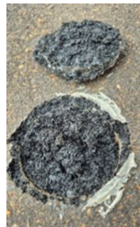
Na mistura asfáltica nova
