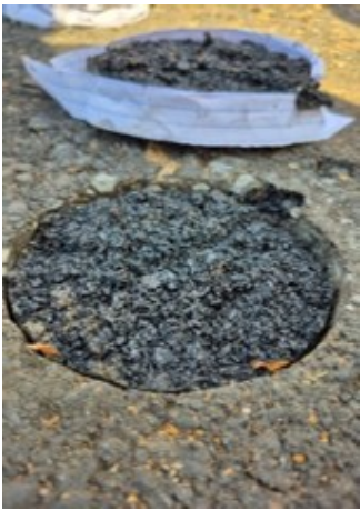
Na mistura asfáltica nova
