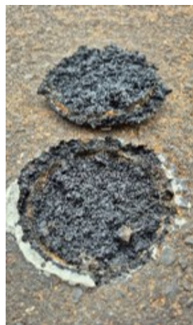
Na mistura asfáltica nova
