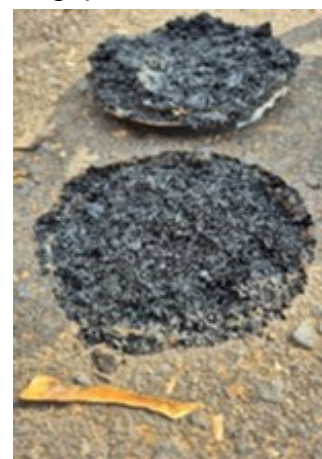
Na mistura asfáltica nova
