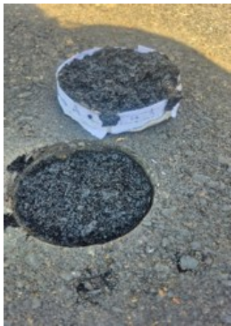
Na mistura asfáltica nova
