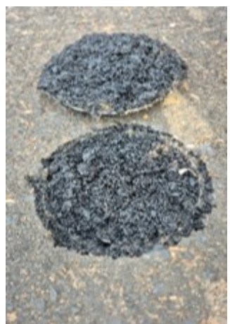
Na mistura asfáltica nova
