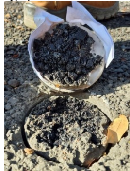
Na mistura asfáltica nova
