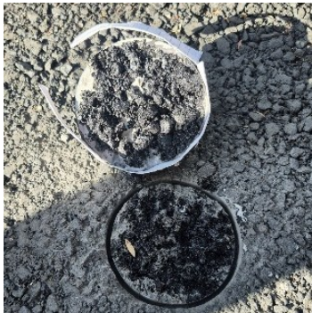
Na mistura asfáltica nova
