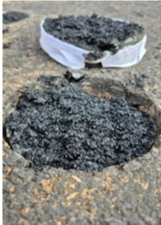
Na mistura asfáltica nova
