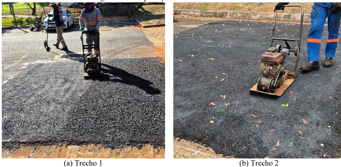
Figura 12. Compactação da nova camada asfáltica
