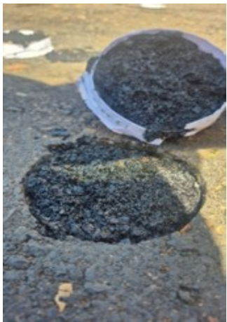
Na mistura asfáltica nova
