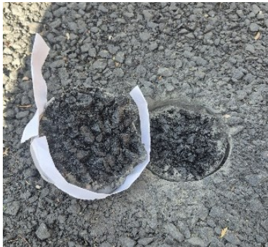
Na mistura asfáltica nova
