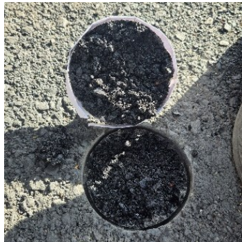
Na mistura asfáltica nova
