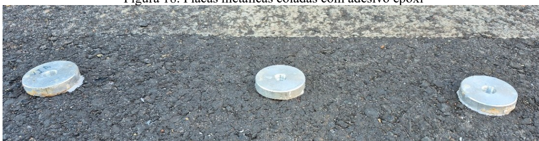
Figura 18. Placas metálicas coladas com adesivo epóxi
