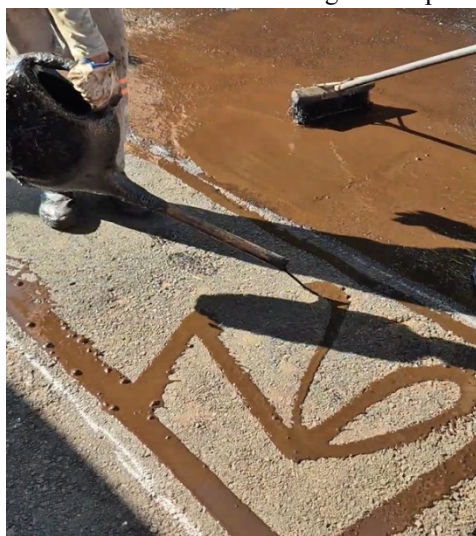
(a) Trecho 1 – durante a aplicação
