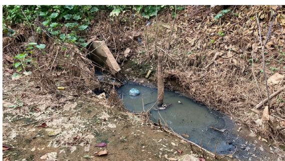
Imagem 14 – Lançamento do esgoto. Fonte: A autora, 2022.
