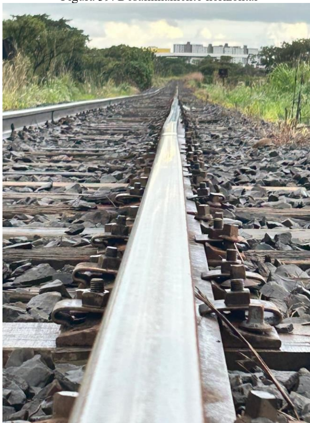
Figura 39: Desalinhamento horizontal
