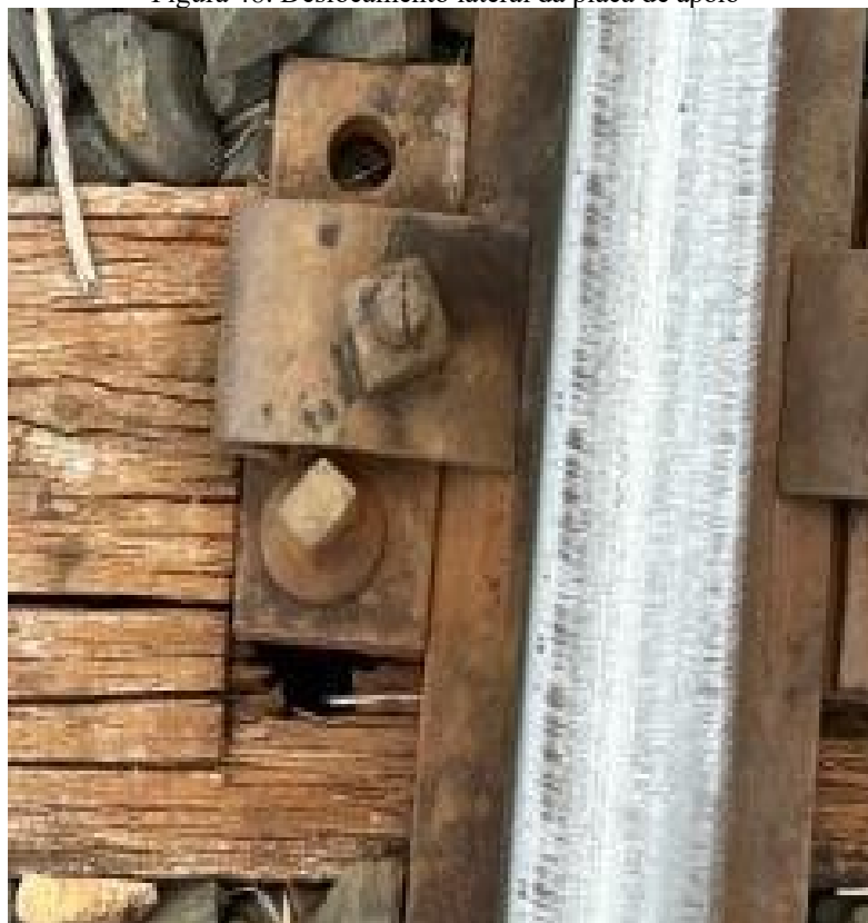
Figura 48: Deslocamento lateral da placa de apoio
