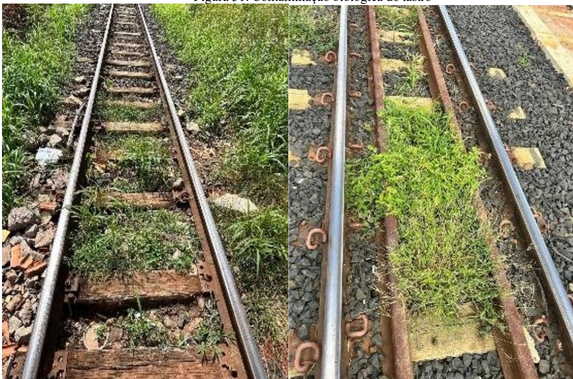
Figura 51: Contaminação biológica do lastro
