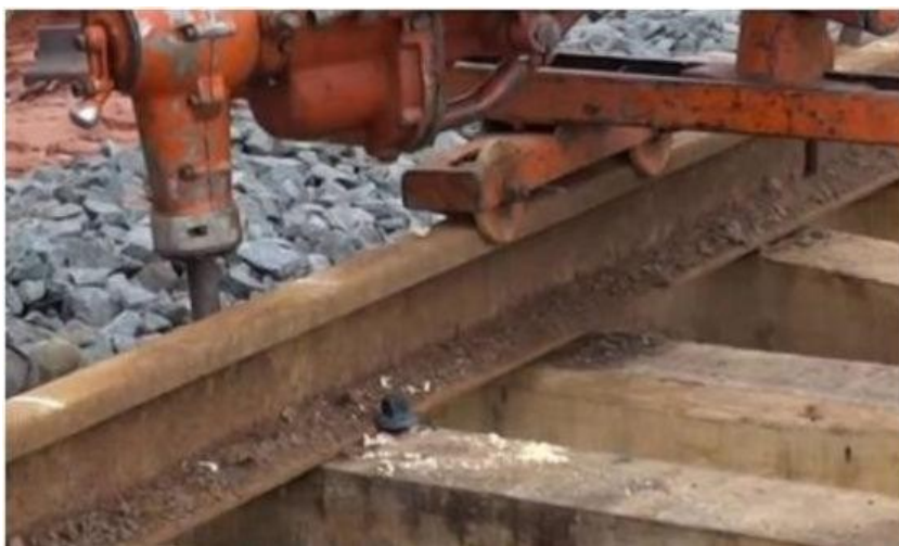
Figura 31: Fixações pregos e parafusos
