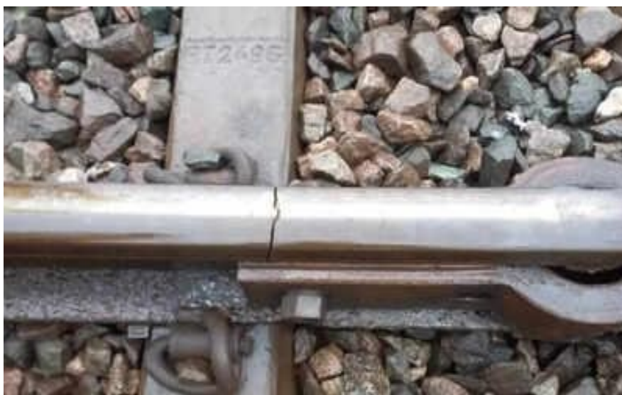
Figura 15: Trincas transversais
