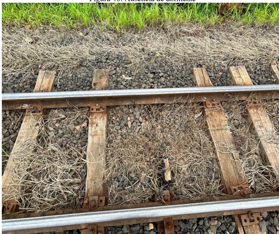
Figura 40: Ausência de dormente
