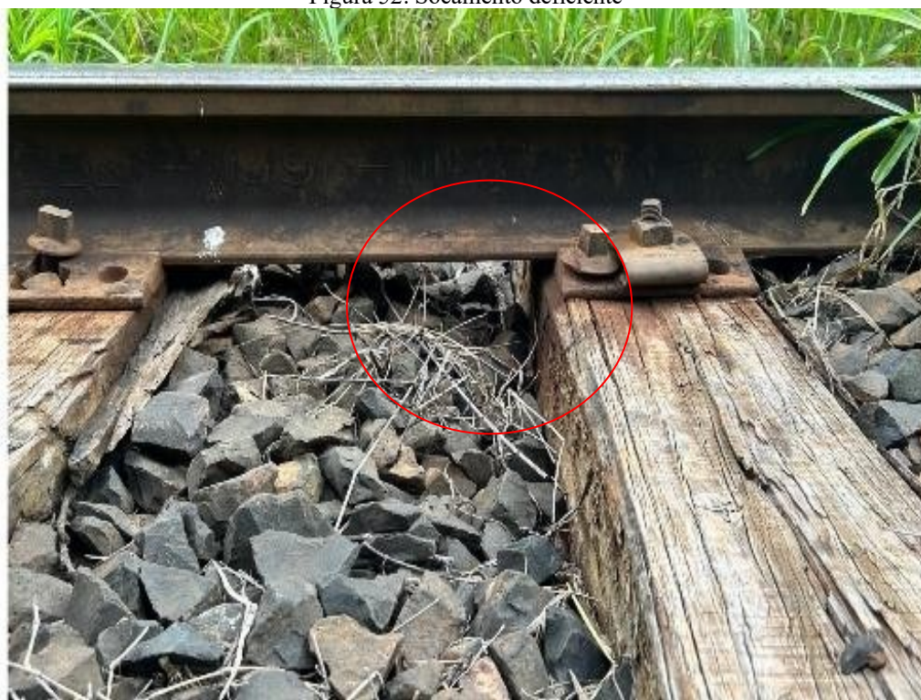
Figura 52: Socamento deficiente
