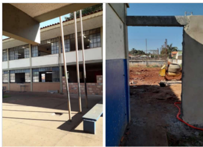
Figura 2 - Refeitório em obra, além, de outros espaços da escola passando por reformas
