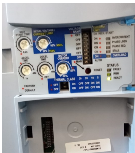
Figura 37 – Rampa de partida na soft-starter em 15 segundos.
