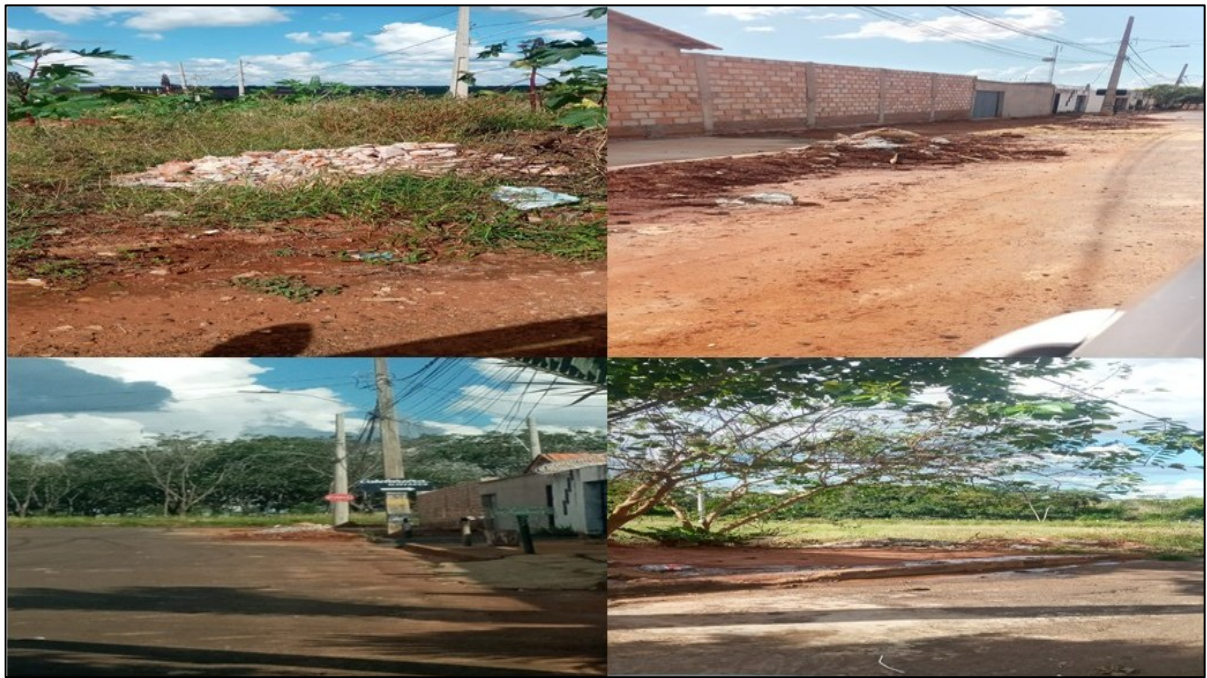
Figura 6 – Ituiutaba (MG): resíduos da construção civil no Bairro Nova Ituiutaba, 2025
