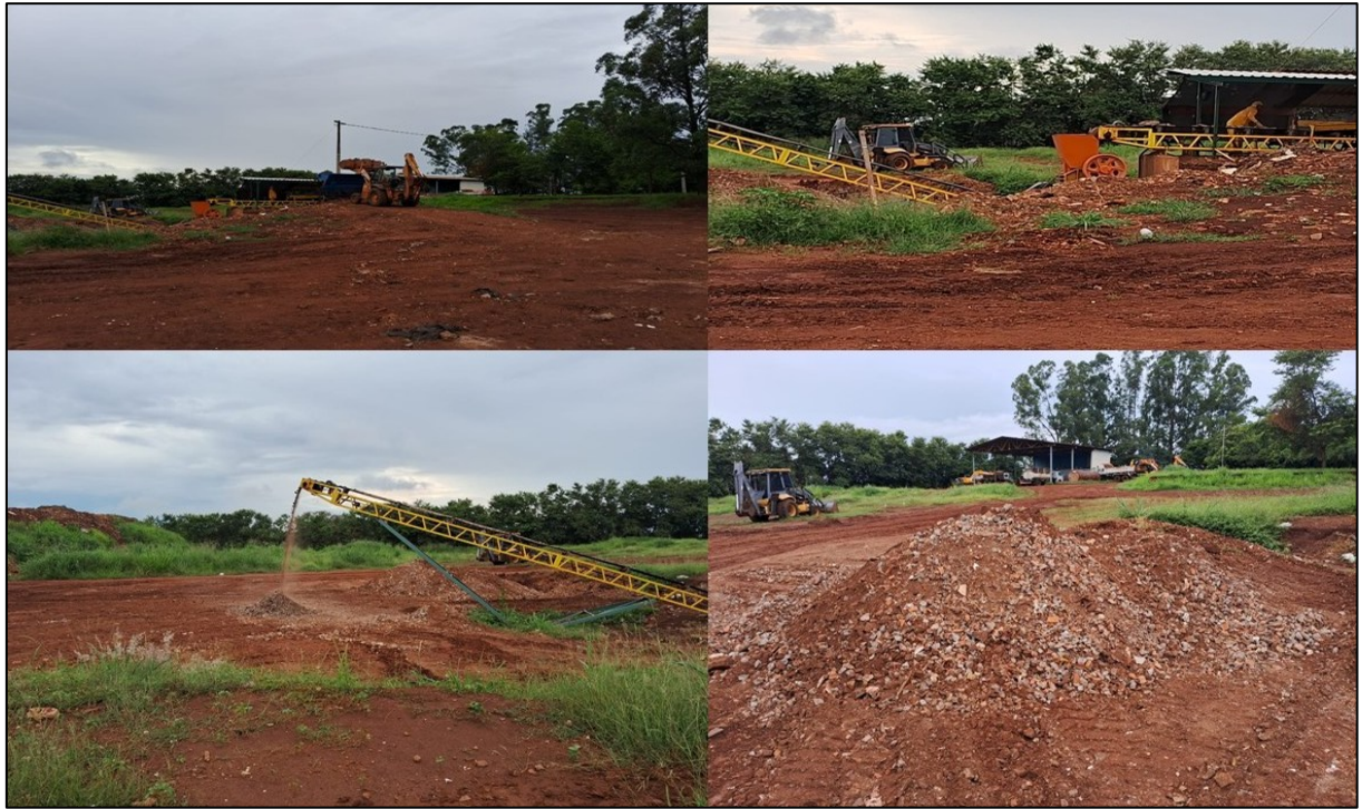
Figura 2 – Ituiutaba (MG): etapas de Trituração dos Resíduos da Construção civil no Aterro Sanitário Municipal, 2025
