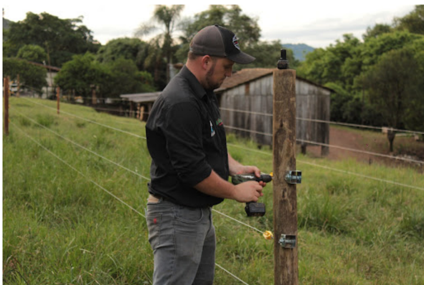
Figura 55 - Profissional capacitado instalando cerca elétrica.
