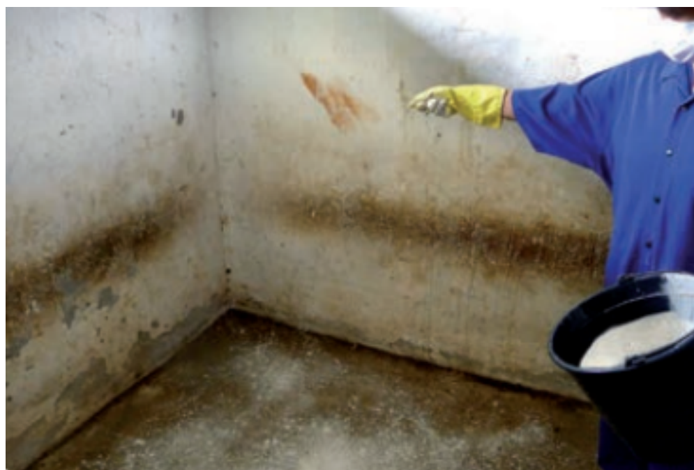
Figura 35 - Funcionário jogando a cal virgem em pó no piso da instalação, formando uma fina camada homogênea.
