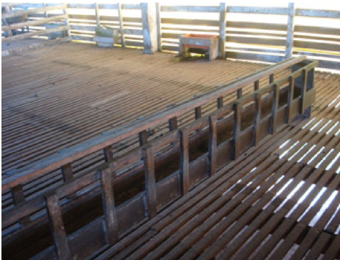
Figura 30 - Instalação com o piso ripado e suspenso.
