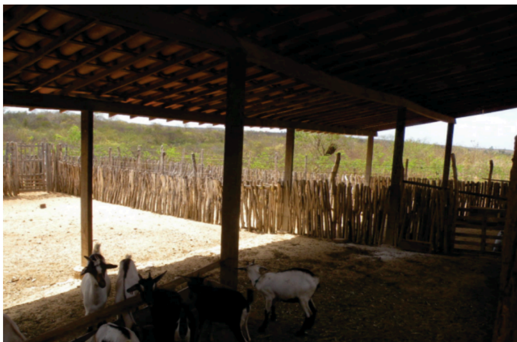
Figura 28 - Exemplo de aprisco também mais básico, com piso de terra batida e cercas de madeira.
