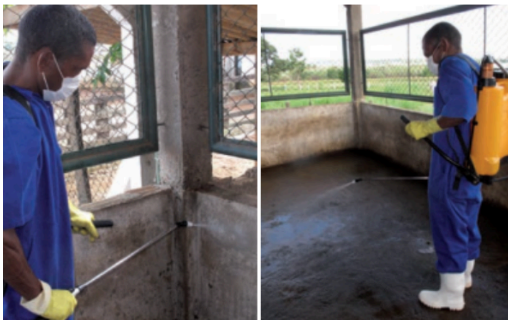
Figura 34 - Pulverização da instalação com cal virgem diluída em água realizada por funcionário com os devidos equipamentos de proteção individual.
