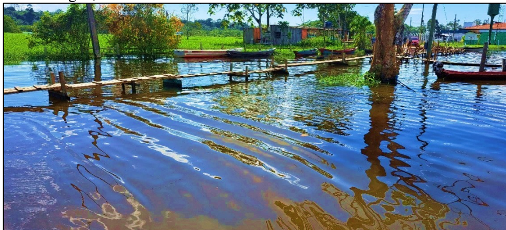
Figura 50 – Iranduba (AM) – Porto da cidade improvisado – Passarelas de madeira construídas sobre a lâmina d’água, 2022.
