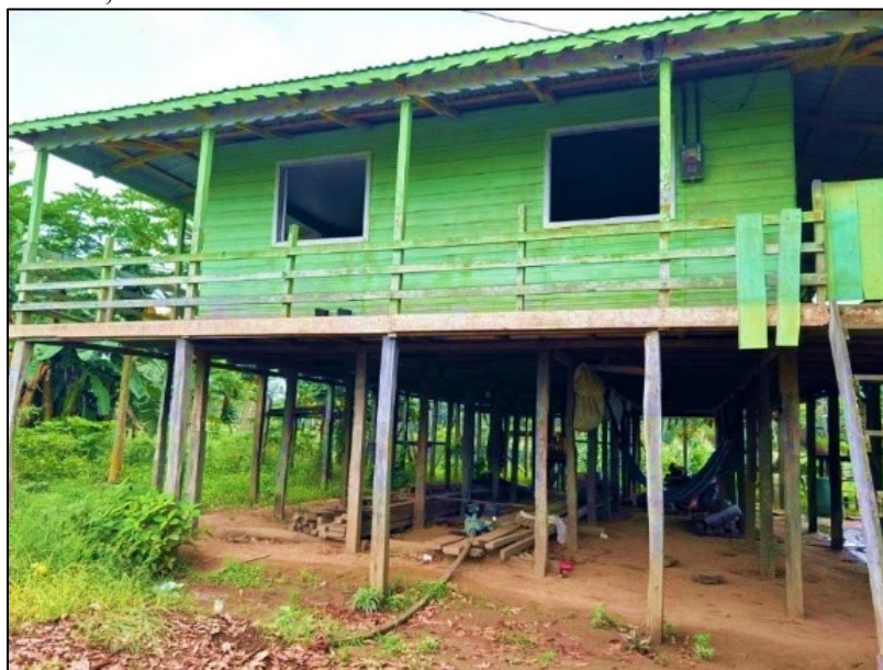
Figura 44 – Iranduba (AM) – Ilha da Muratu – Residência modificada por causa das cheias extremas no Rio Solimões, 2024.
