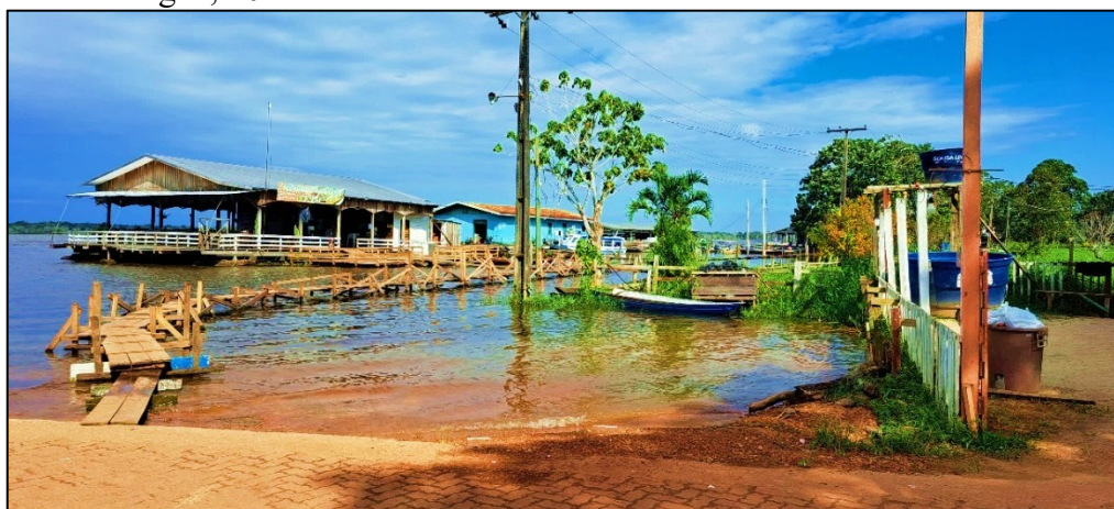
Figura 51 – Iranduba (AM) – Porto da cidade improvisado – Passarelas de madeira construídas sobre a lâmina d’água, 2022.
