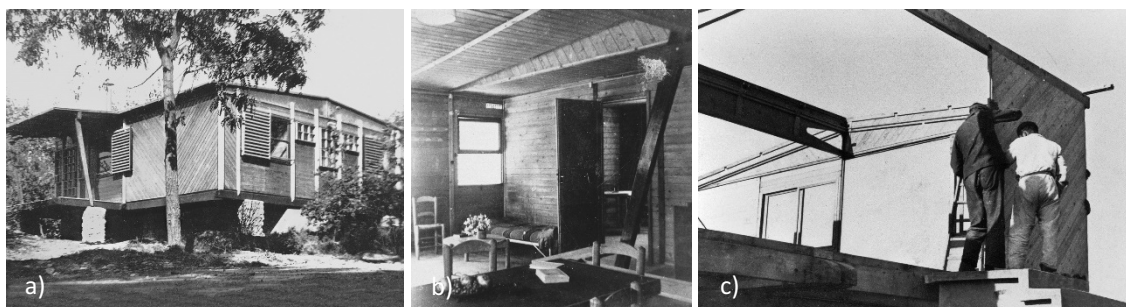
Figura 19 – Sequência de imagens relativas à construção desmontável F 8 x 8 m B.C.C. a) Vista externa; b) Vista interna; c) Instalação dos painéis.
