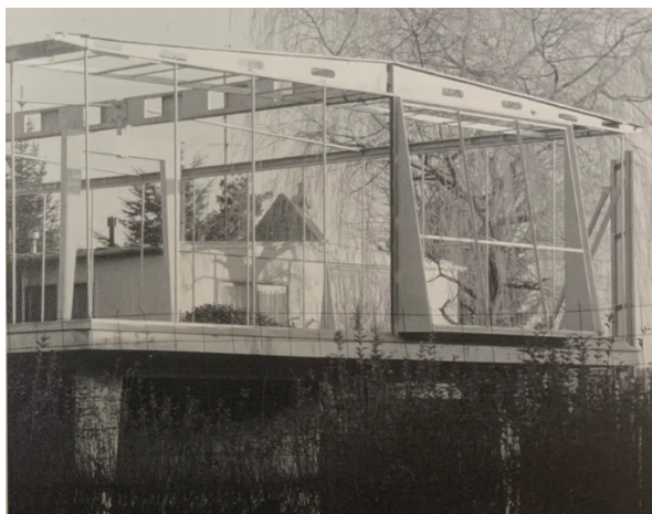
Figura 75 - Montagem sobre estrutura de concreto – Casa Standard.
