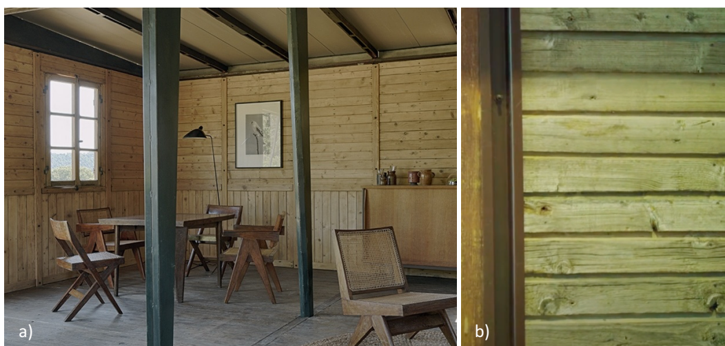
Figura 46 – Acabamento dos painéis de vedação vertical – Construção desmontável para vítimas de guerra. a) Acabamento face interna; b) Acabamento face externa.
