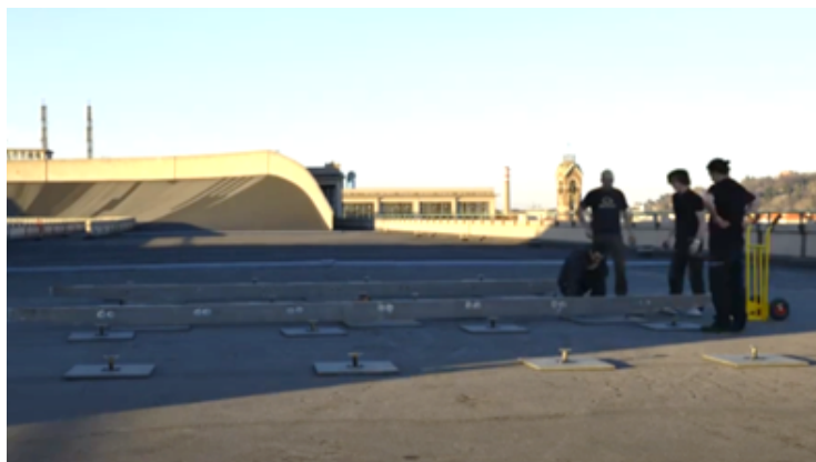
Figura 66 - Bases metálicas de estruturação do piso – Casa Standard.
