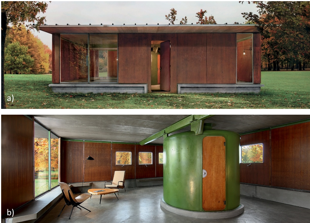
Figura 87 - Fotos da reconstrução – Casa para Melhores Dias. Vista externa – juntas invisíveis entre os painéis; b) vista interna – juntas visíveis entre os painéis.
