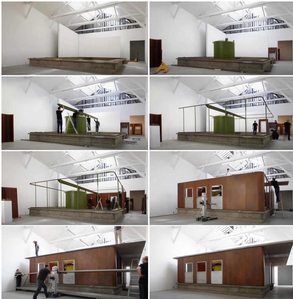
Figura 90 – Sequência de imagens referentes ao processo de remontagem – Casa para Melhores Dias.
