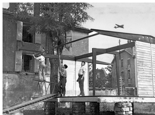
Figura 48 - Processo de montagem – Construção desmontável para vítimas de guerra 6x6.
