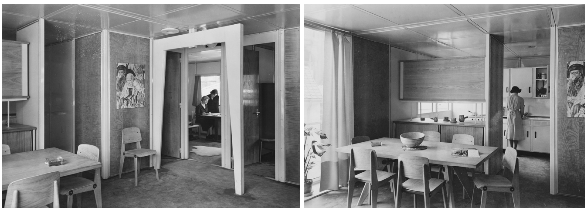
Figura 73 - Imagens referentes à utilização de painéis de forro em alumínio – Casa Standard.
