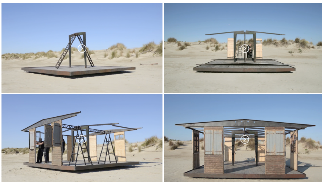
Figura 49 - Processo de remontagem da Construção desmontável para vítimas de guerra 6x6 pela Galerie Patrick Seguin.
