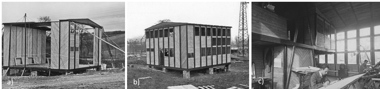
Figura 18 – Sequência de imagens referentes ao edifício de projetos da S.C.A.L., 1939 a) Montagem do edifício; b) Finalização do edifício; c) Vista interna do edifício em utilização.
