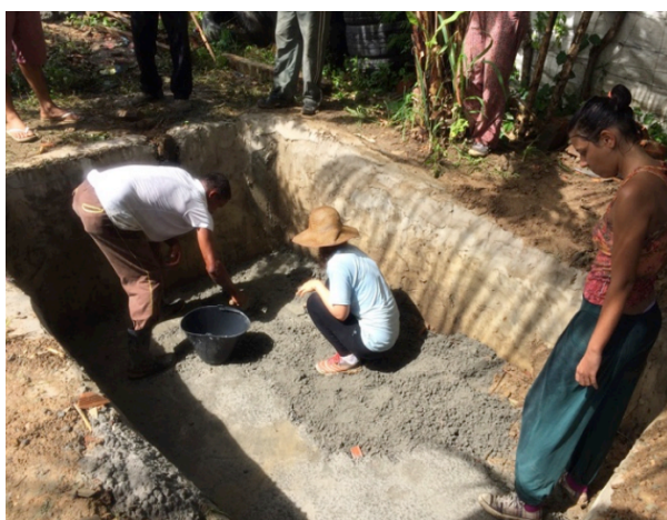
Figuras 17 e 18: À esquerda, a reconstrução da laje inferior e, à direita, a montagem da fossa.
