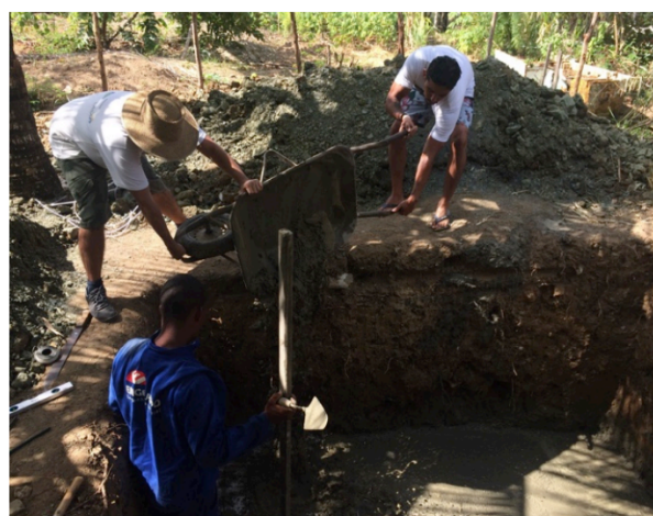
Figuras 15 e 16: À esquerda, a preparação do concreto e das malhas pop. À direita, a construção da laje da caixa para a fossa. Ambas atividades durante o EREA.
