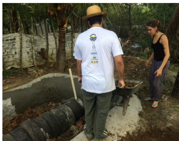
Figuras 17 e 18: À esquerda, a reconstrução da laje inferior e, à direita, a montagem da fossa.
