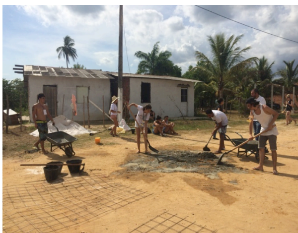
Figuras 15 e 16: À esquerda, a preparação do concreto e das malhas pop. À direita, a construção da laje da caixa para a fossa. Ambas atividades durante o EREA.
