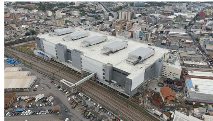
Figura 59 Em 2020 houve a demolição da Feirinha da Madrugada, e a criação do shopping Circuito de Compras. Fonte: PlanService, 2021.
