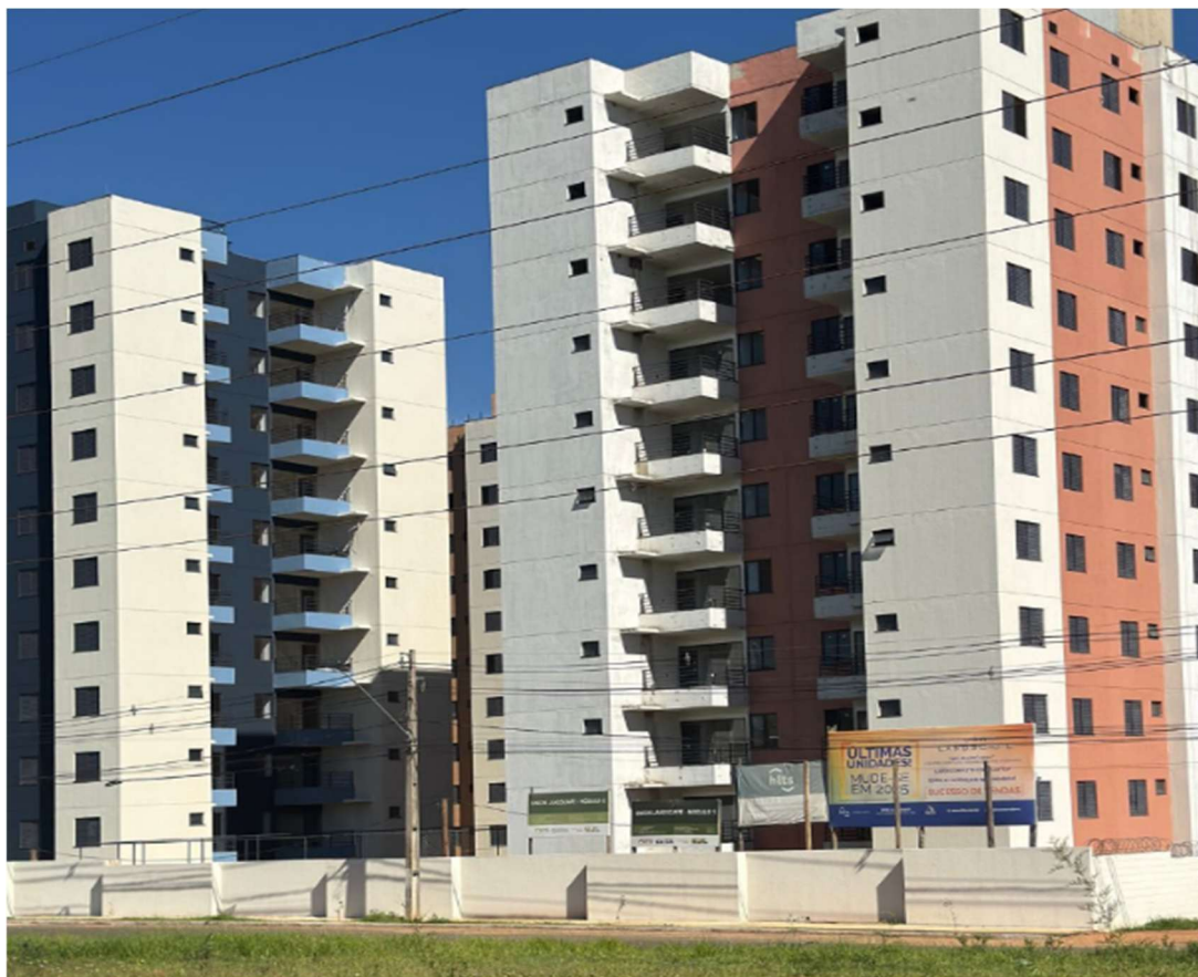
Figura 25 - Novos empreendimentos no Bairro Shopping Park
