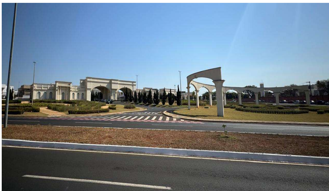
Figura 29 - Condomínio bairro Cidade Jardim
