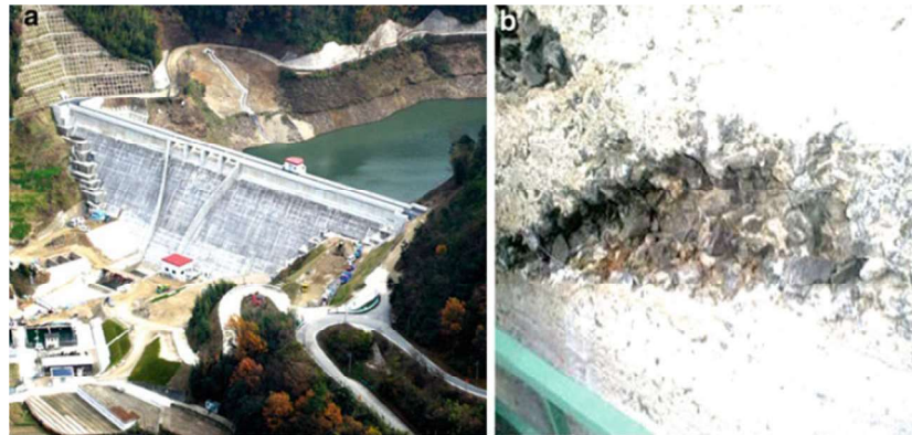
Figura 5 – Represa Mitaka na província de Hiroshima, Japão: (a) barragem Mitaka; (b) danos causados no concreto pela erosão no montante da represa.
