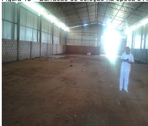
Barracão onde foi instalada Cooptal 2014
