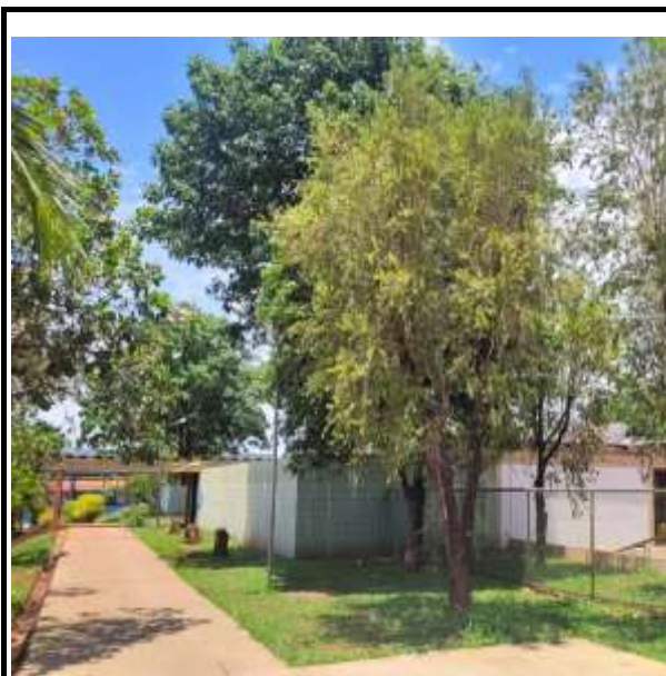
Figura 1: Entrada de acesso à Educação Infantil do CAIC.
