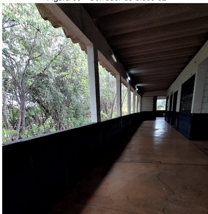
Figura 09 - Corredor do bloco 02
