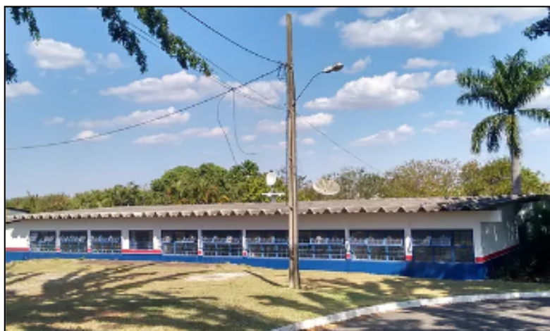
Figura 06 - Vista do bloco 01 da escola
