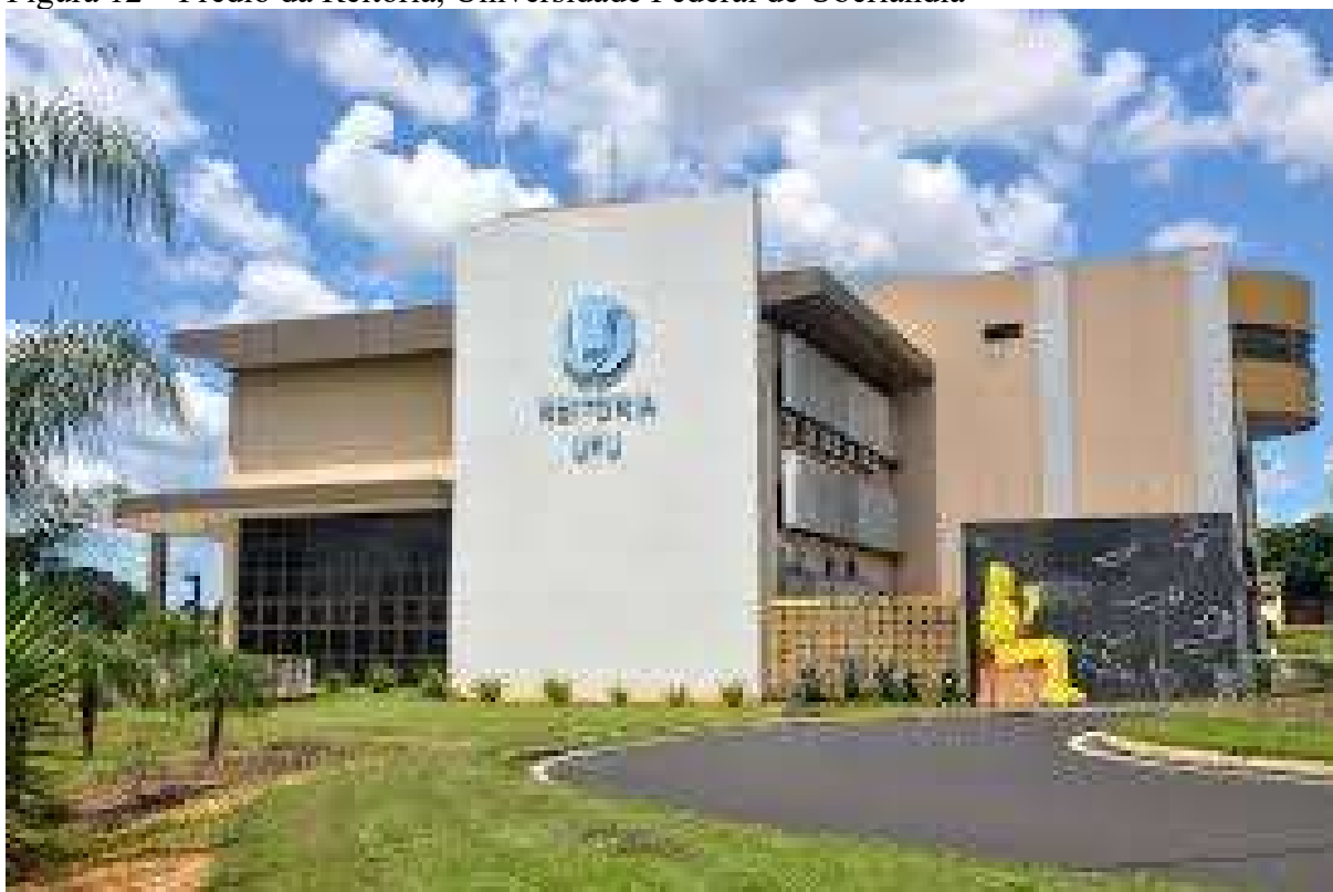
Figura 12 – Prédio da Reitoria, Universidade Federal de Uberlândia
