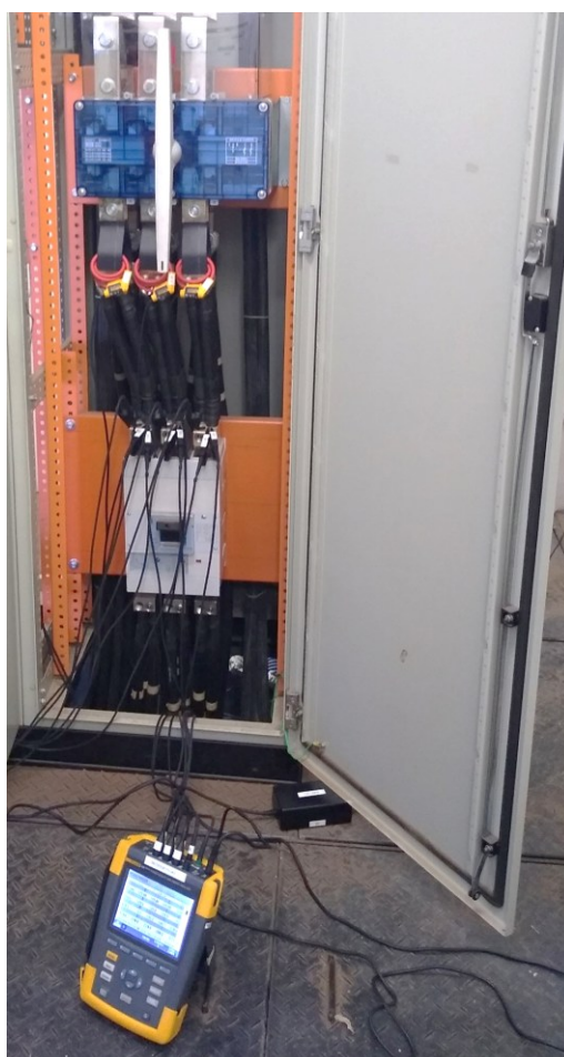
Figura 39 – Sistema de Medição Implementado – Instalação no Campus Umuarama (UFU).
