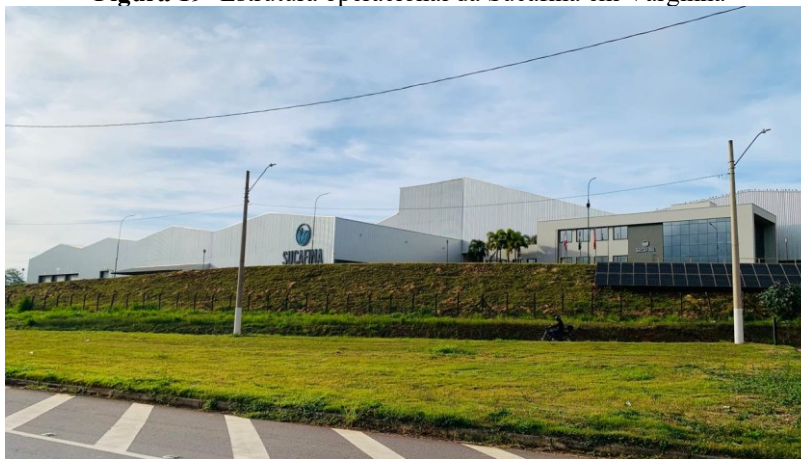
Figura 19- Estrutura operacional da Sucafina em Varginha
