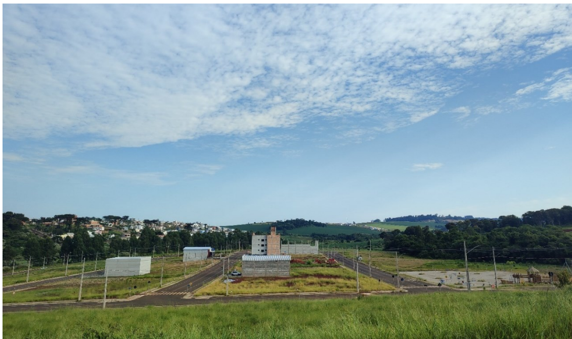
Figura 25 - Expansão urbana na região Oeste de Chapecó
