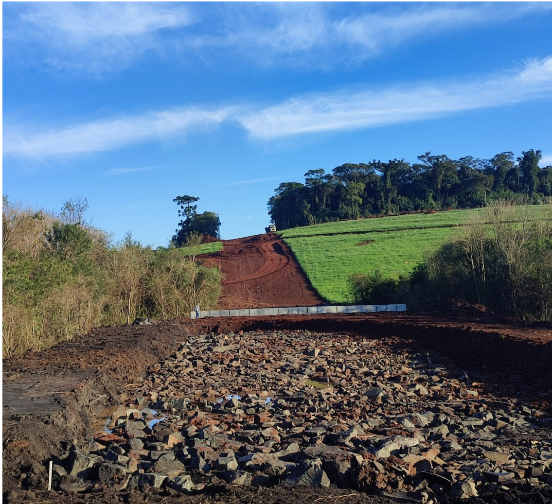
Figura 27 - Obra de ligação entre área de expansão urbana e loteamento existente
