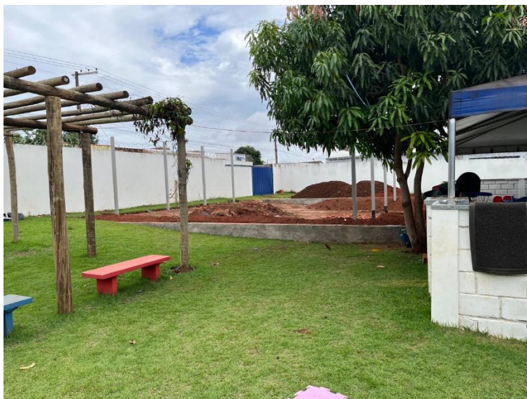
Figura 32 - Obra realizada na unidade escolar – Unidade Ipê Amarelo
