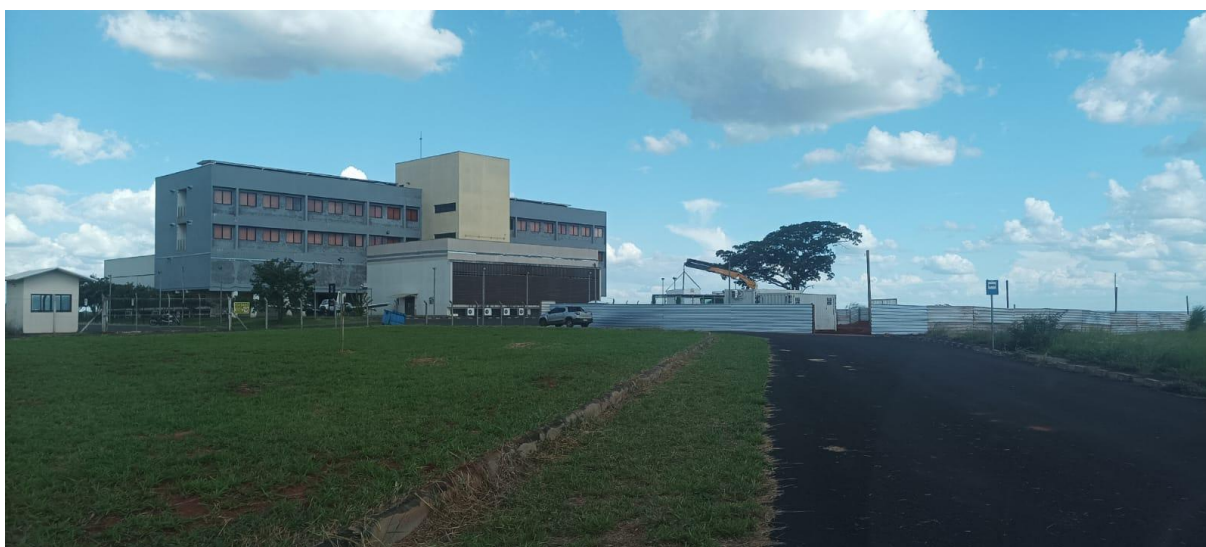
Figura 37. Canteiro de obras para construção do prédio do túnel de vento – CPAERO/UFU/FEMEC – Campus Glória.
