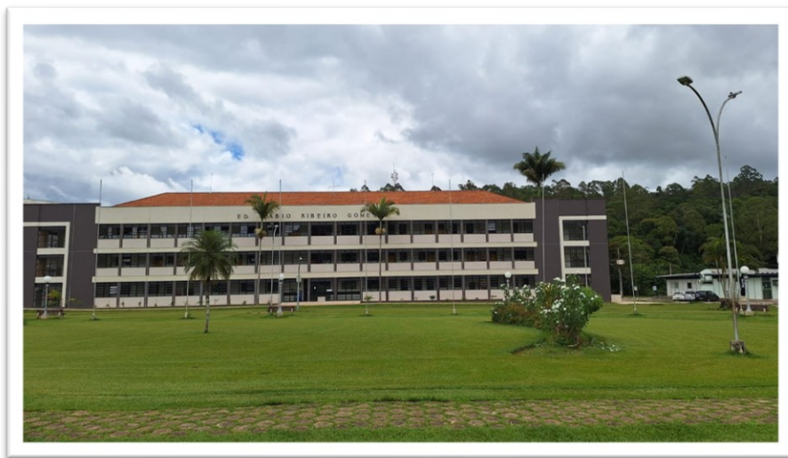
Figura 1 – Edifício Fábio Ribeiro Gomes, antigo Departamento de Química da UFV.
