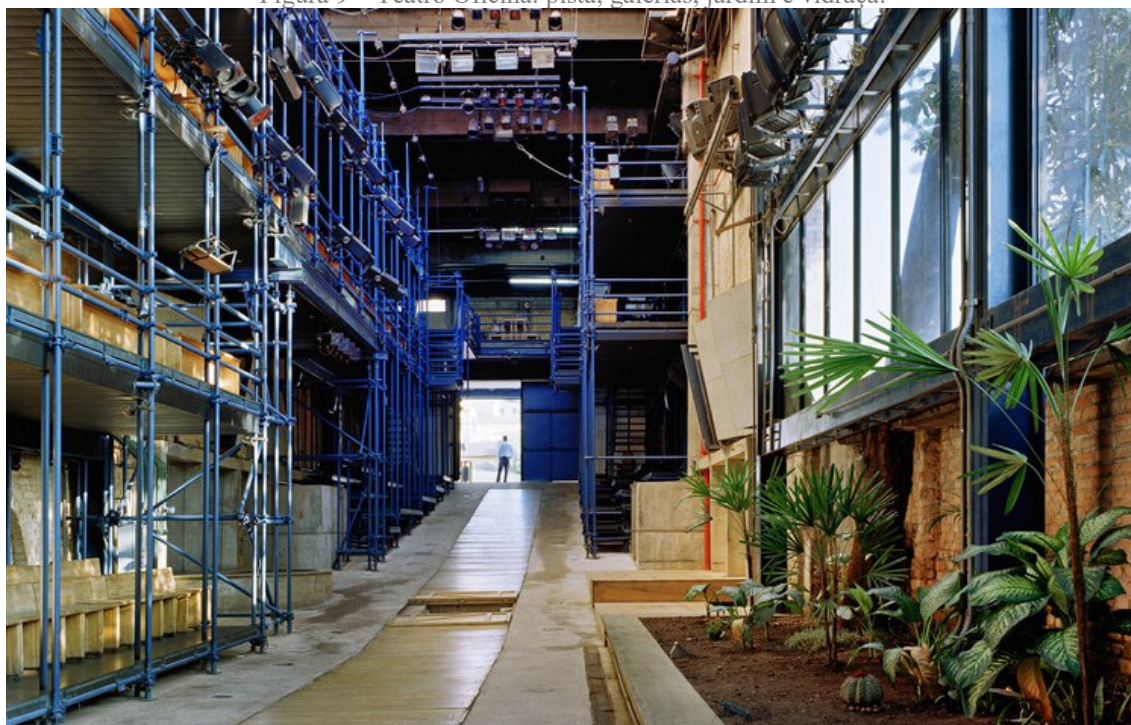
Figura 9 – Teatro Oficina: pista, galerias, jardim e vidraça.
