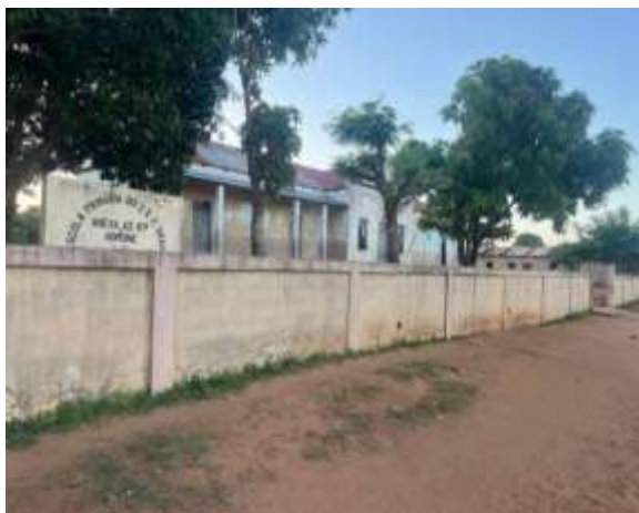
FIGURA 7 - Parte frontal e muro da Escola Fonte: Acervo de Julião Bambo, 2024.
