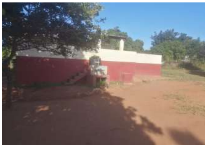
FIGURA 17 - Sanitários escolares Fonte: Acervo de Julião Bambo, 2024.
