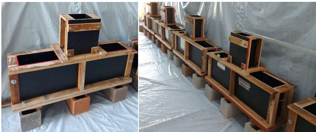
Figura 4.12 - Montagem das formas
