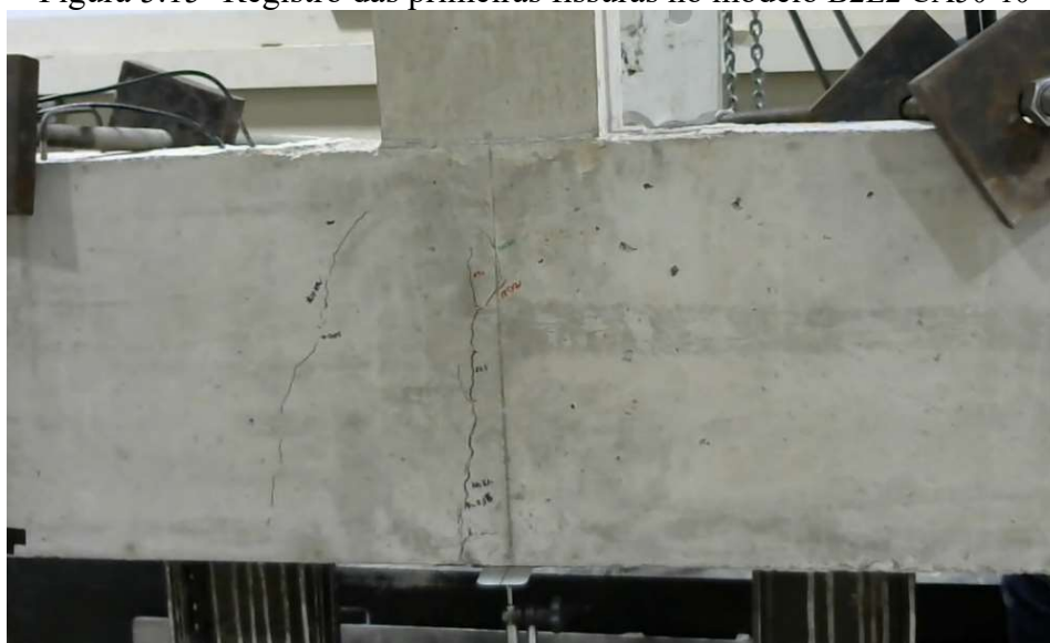
Figura 5.15 -Registro das primeiras fissuras no modelo B2E2 CA50-10
