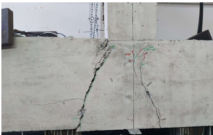
Figura 5.23 - Ruptura do modelo B5E2 GFRP-10 ANC
