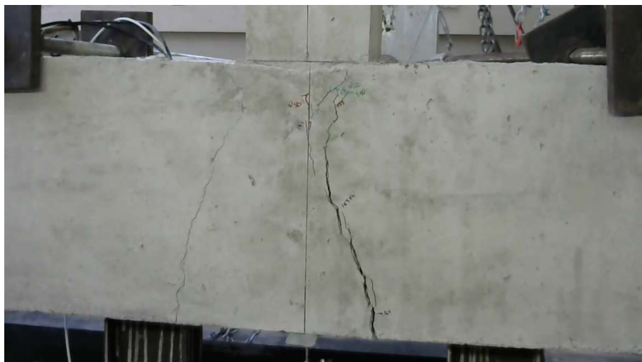
Figura 5.22 - Registro das primeiras fissuras no modelo B5E2 GFRP-10 ANC
