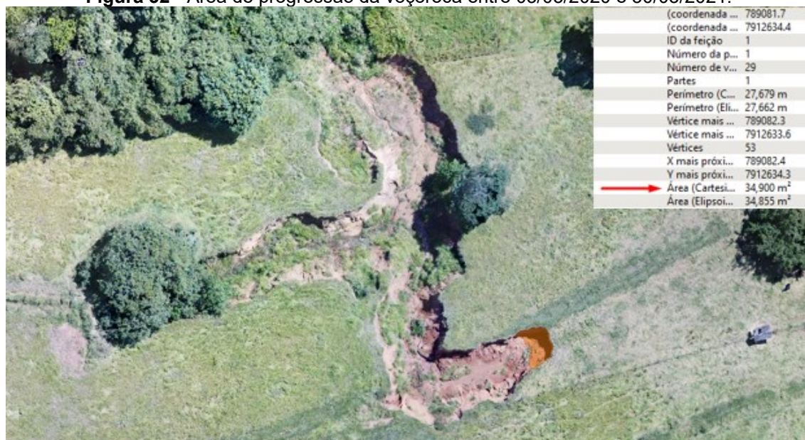
Figura 32 - Área de progressão da voçoroca entre 03/03/2020 e 30/03/2021.
