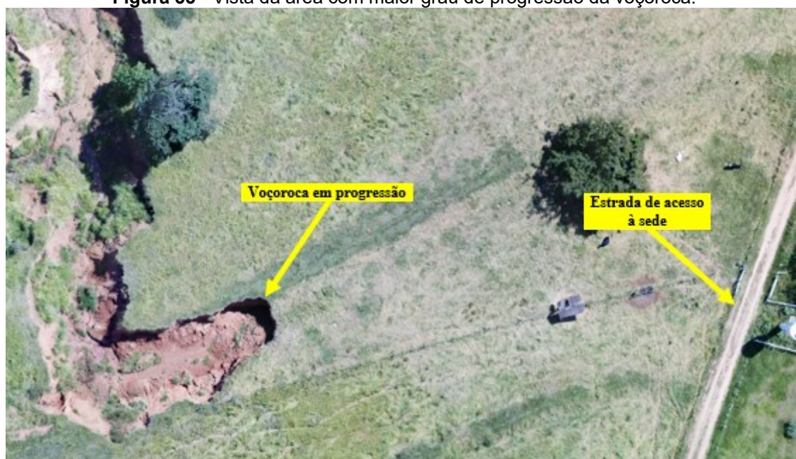
Figura 33 - Vista da área com maior grau de progressão da voçoroca.
