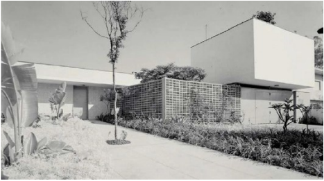
Residência Castor Delgado Perez
