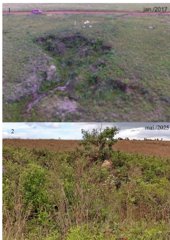
Figura 37 - Feição Erosiva em anos diferentes
