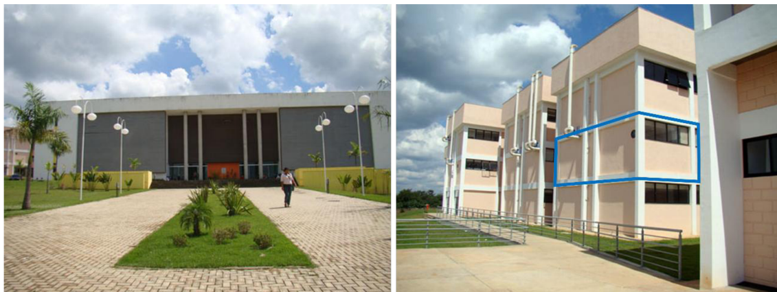
Figura 23. Campus Centro-Oeste D. Lindu da Universidade Federal de São João del-Rei, Divinópolis, MG. À esquerda, o bloco A, na entrada do campus, que comporta as salas administrativas. À direita, o bloco B, onde está destacado o Laboratório de Fisiologia Animal (LAFIA).
