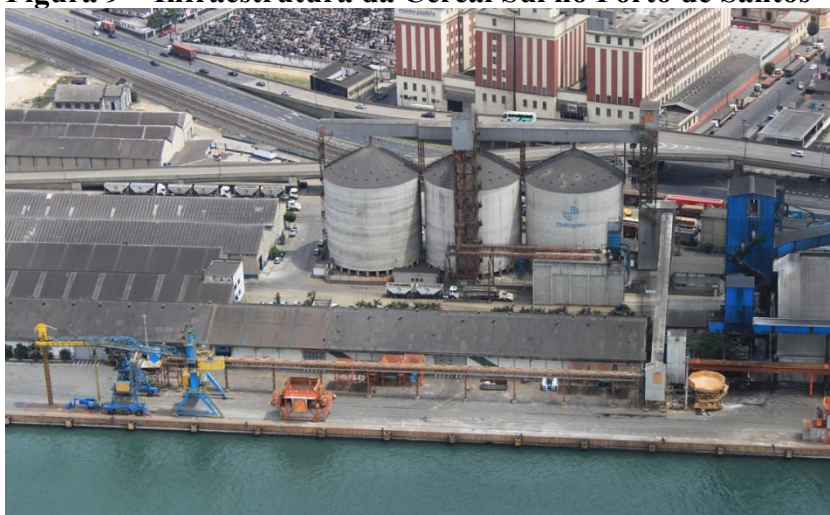
Figura 9 – Infraestrutura da Cereal Sul no Porto de Santos
