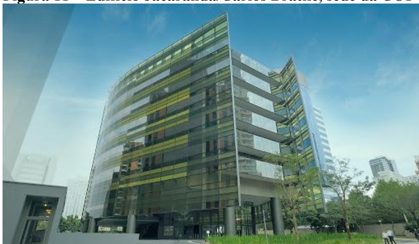
Figura 11 – Edifício Jacarandá/Carlos Bratke, sede da COFCO Intl. no Brasil
