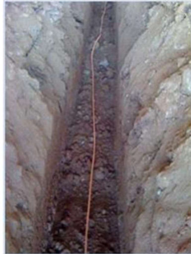
Figura 9: Fio condutor estendido em uma vala.
