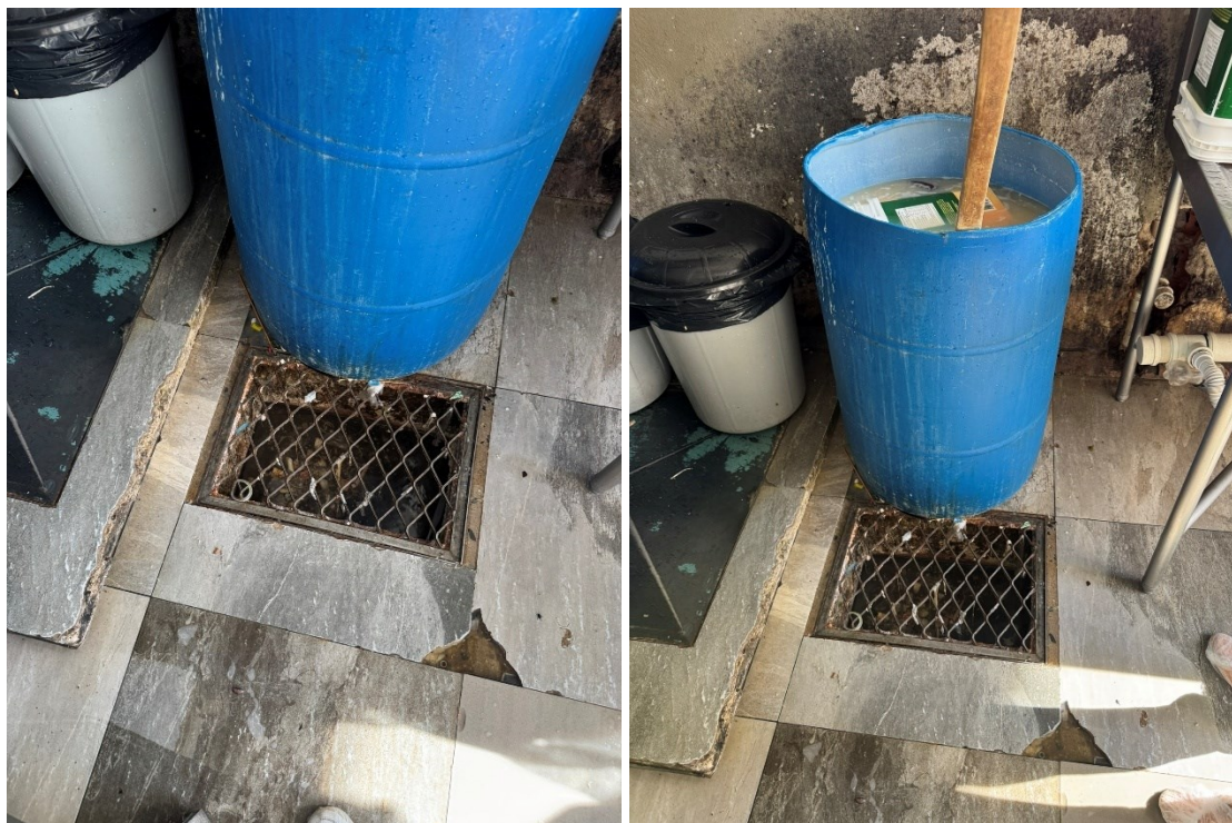
Figura 9 – Ralos sem proteção, ausência de barreiras físicas entre áreas limpas e sujas e possibilidade de acesso de vetores na área de manipulação.
