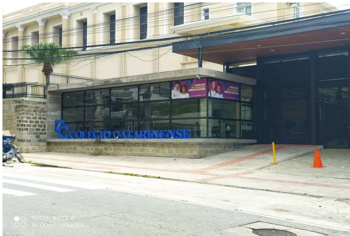
Fotografia 4: Fachada atual do Colégio Catarinense
