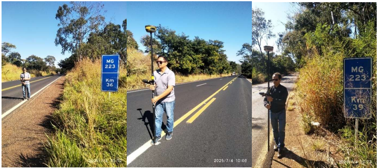
FIGURA 5 – Aquisição de pontos GNSS na rodovia.
