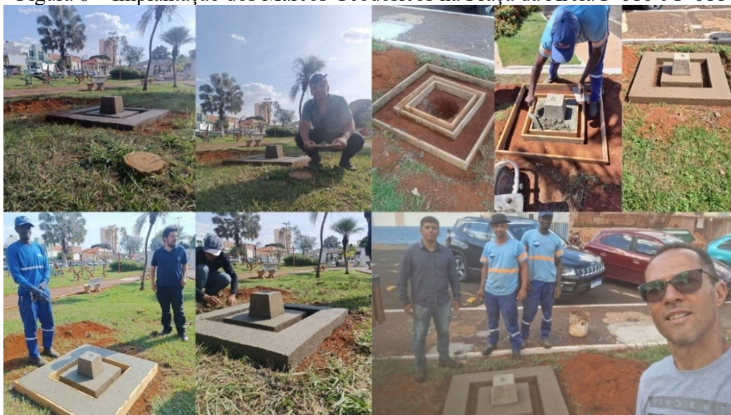
Figura 8 – Implantação dos Marcos Geodésicos na Praça da Areia P-010 e P-011
