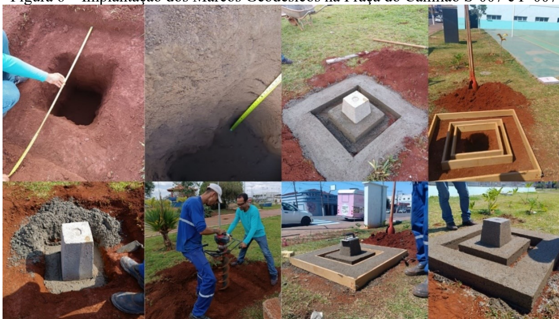
Figura 6 – Implantação dos Marcos Geodésicos na Praça do Camilão S-007 e P-007
