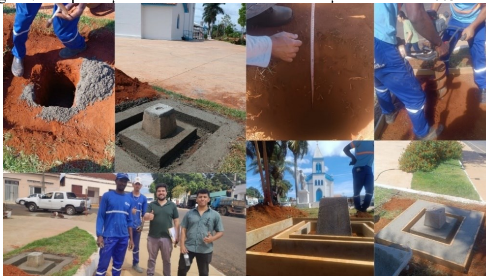
Figura 7 – Implantação dos Marcos Geodésicos na Praça do Rosário S-003 e P-003
