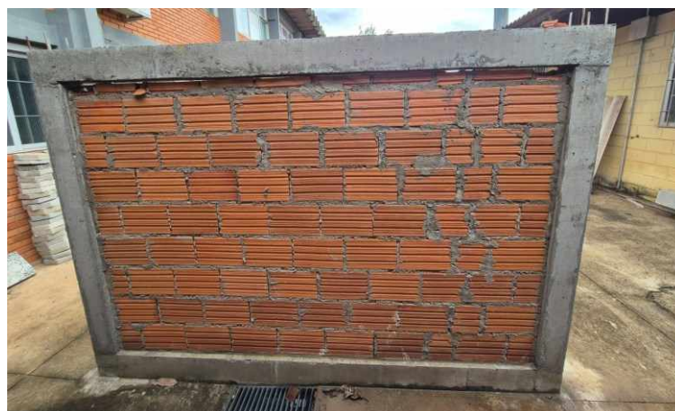
Figura 14: Painel de bloco cerâmico.
