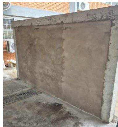
Figura 15: Argamassas aplicadas nos painéis.
