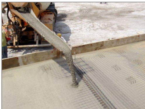
Figura 1- Lançamento de concreto autoadensável
