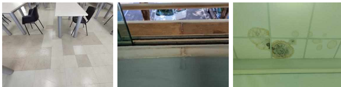
Figura 70 – Exemplos de patologias observadas nos pisos, paredes e forros.
