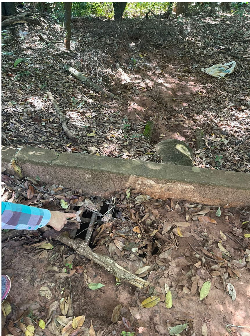
Figura 52. “Boca de lobo” entupida no início da Trilha da Ravina
