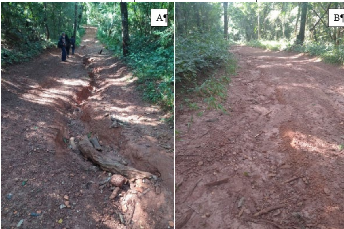
Figura 39. A. Manifestação de feição erosiva em forma de sulco bem entalhado no solo. B. Trilha do Cerradão com destaque para as marcas do escoamento superficial no leito da via
