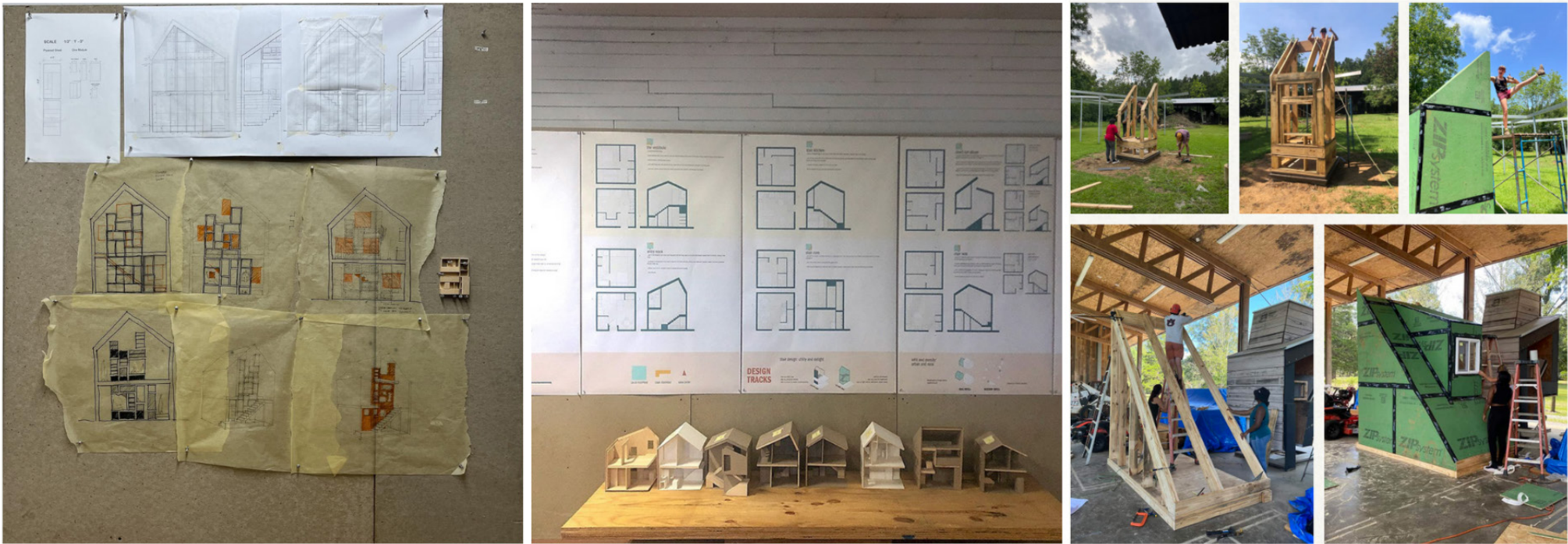
Figura 20 – Processo de desenvolvimento projetual. (a) Estudos com desenhos. (b) Estudos de layout e composições por meio de desenhos e maquetes. (c) Elaboração dos protótipos “casinha de cachorro” e “mansarda”. Fonte: Rural Studio.
