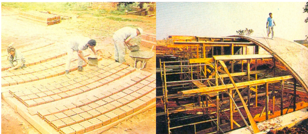
Figura 14 – (a) Protótipo de painéis curvos (b) Última fase da pesquisa para desenvolvimento dos painéis curvos e confecção de arcos. Fonte: Projetar, na realidade da fronteira.
