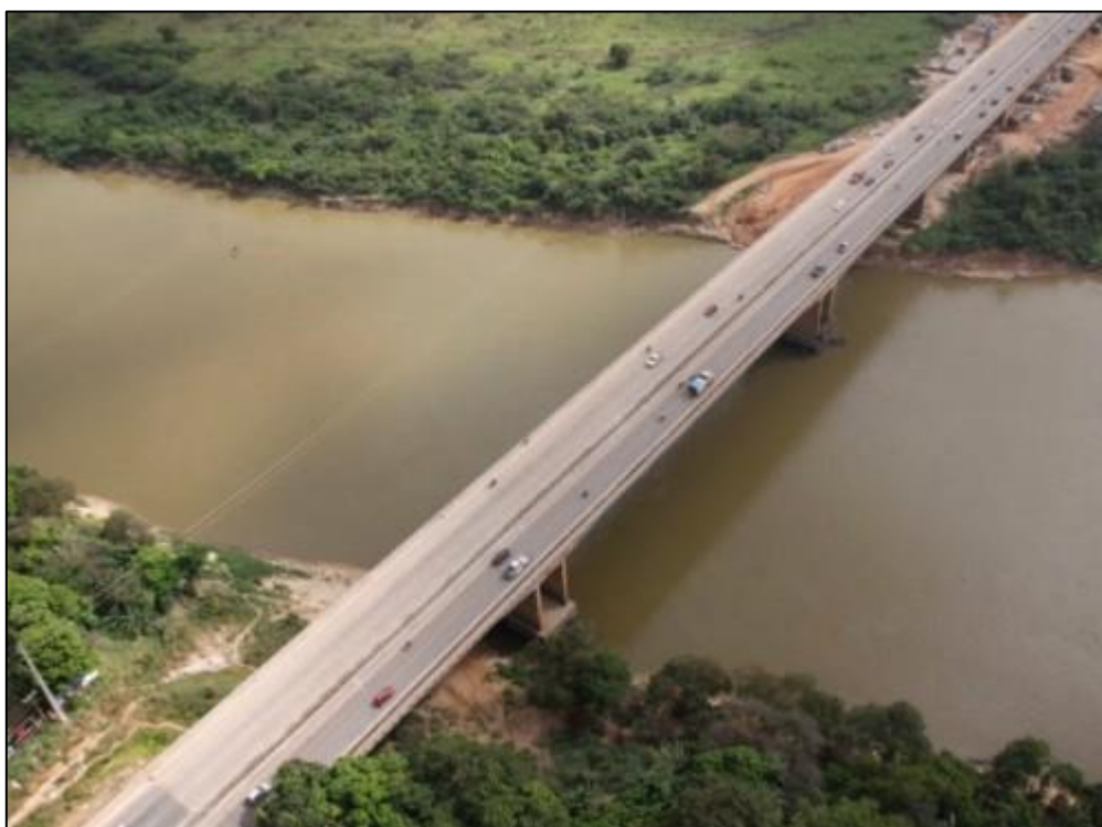
Figura 7 - Ponte sobre o Rio Itacaiúnas, ligando os núcleos Nova Marabá e Cidade Nova.
