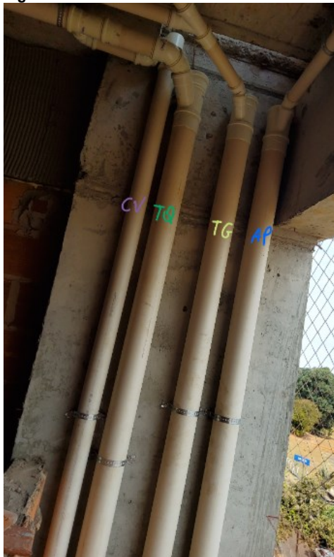
Figura 21: Problemas – Prumadas – Colocar fita
