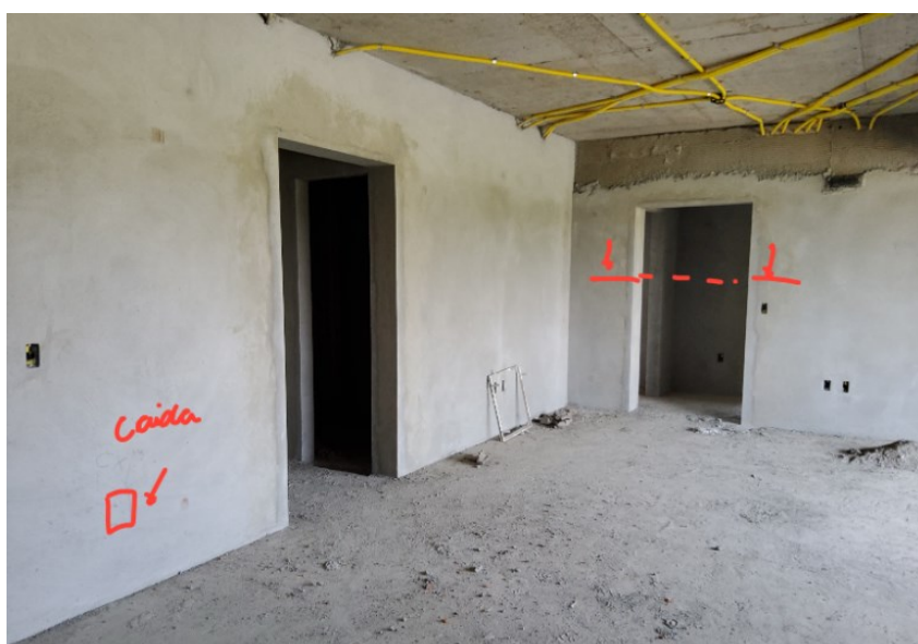
Figura 14: Sem alinhamento e Caixa elétrica obstruída
