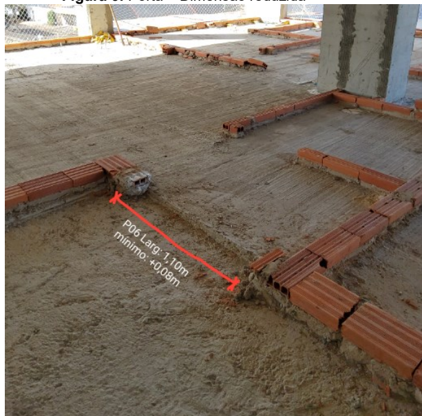
Figura 6: Porta – Dimensão reduzida
