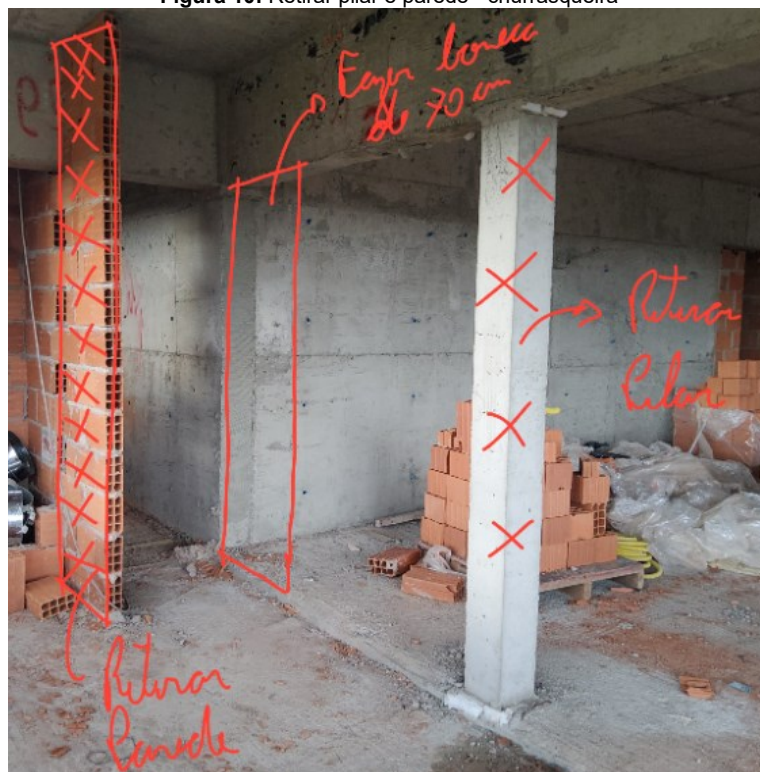
Figura 10: Retirar pilar e parede - churrasqueira
