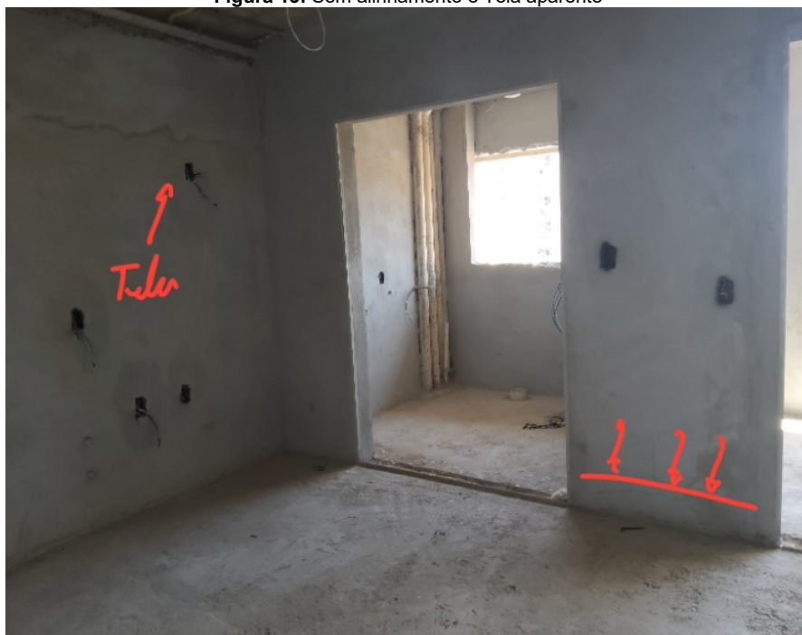
Figura 13: Sem alinhamento e Tela aparente
