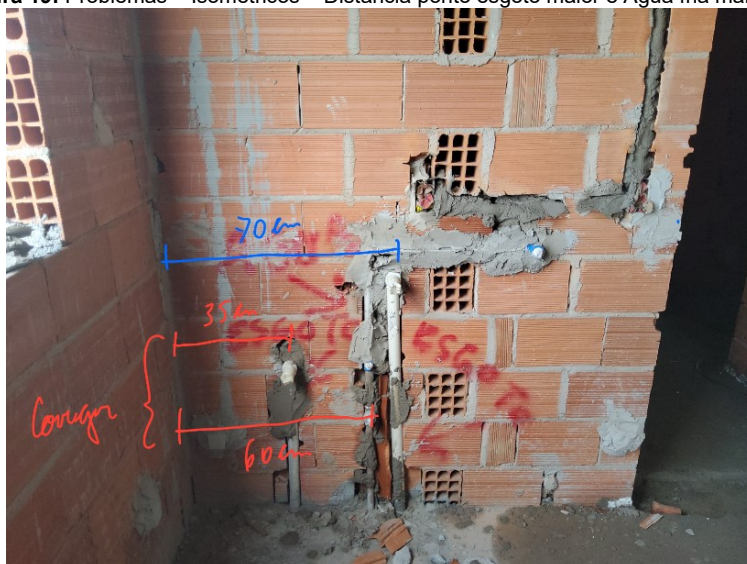
Figura 19: Problemas – Isométricos – Distância ponto esgoto maior e Água fria maior
