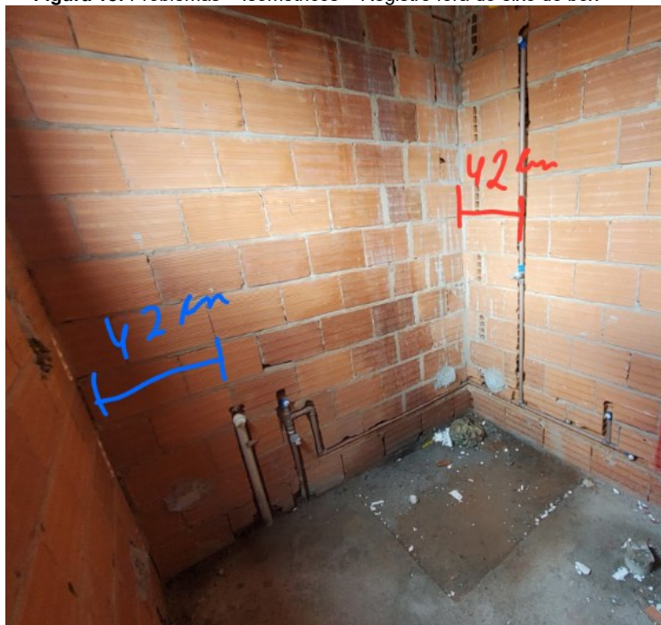
Figura 18: Problemas – Isométricos – Registro fora do eixo do box
