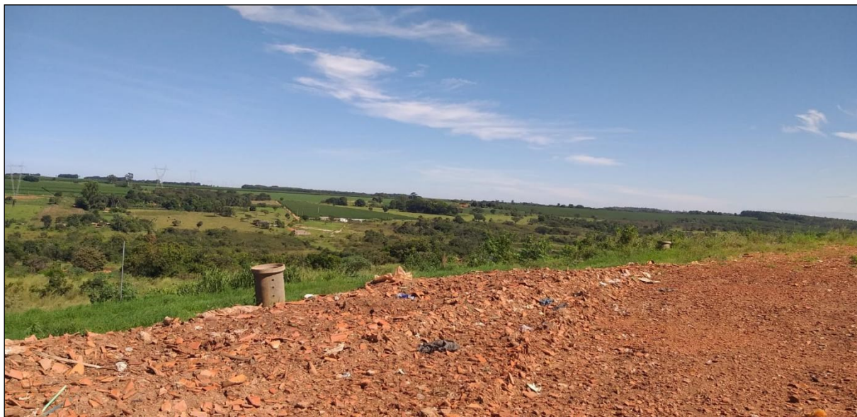
Figura 5: Cacos de telhas usados nos taludes para oferecer maior estabilidade à estrutura.
