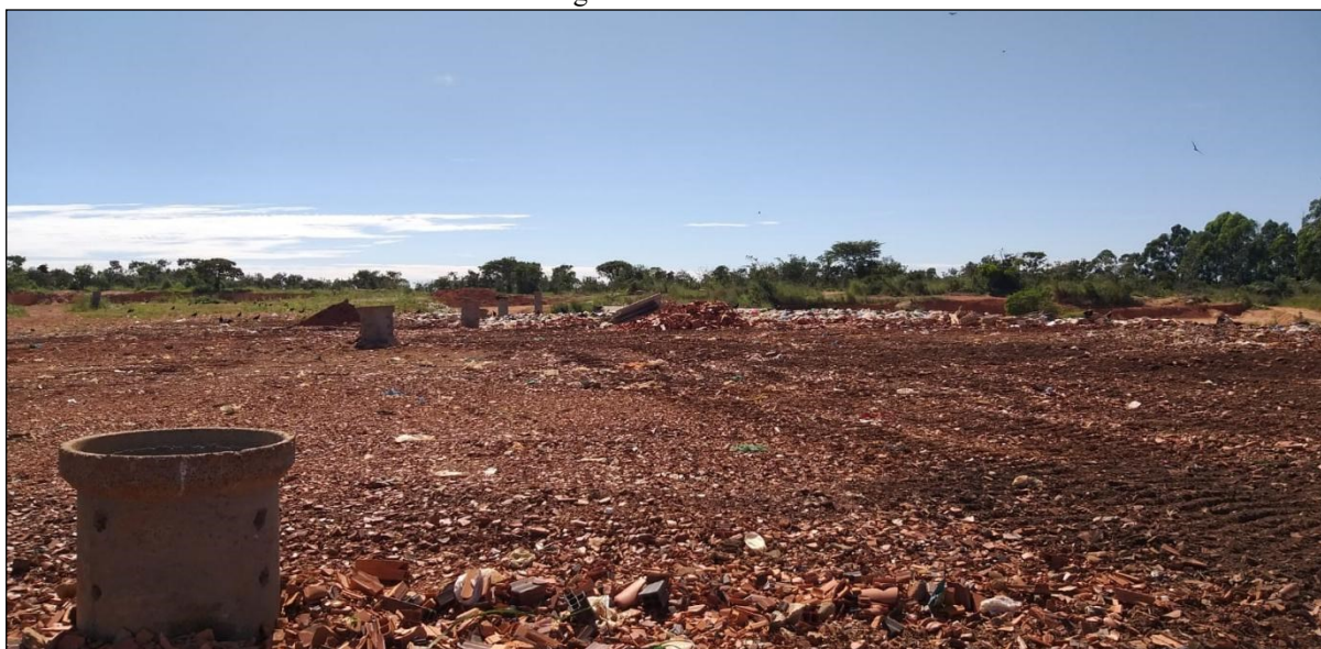
Figura 3 - Rede de chaminés por onde são exalados os gases na plataforma 2, através do sistema de drenagem interna do aterro.
