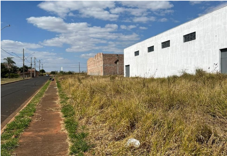
Fig. 062: Fundo dos lotes empresariais, onde deveria ser implantado um cinturão verde com densa arborização. Fonte: Autora, 2025.
