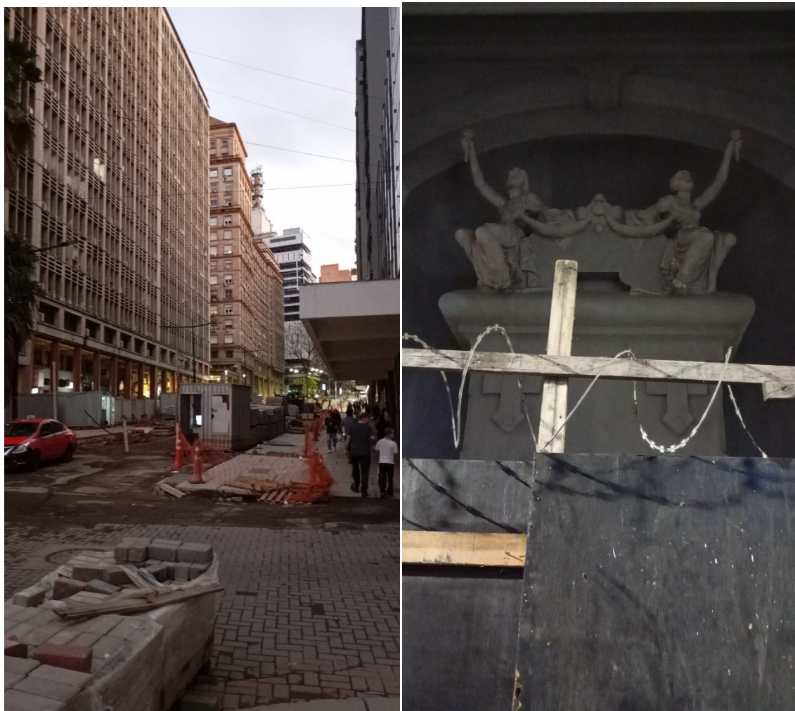
Imagem 33 e 34 – fotografias durante a visita em Porto Alegre durante 2024, construções no acesso à avenida (primeira imagem) e estruturas de madeira e arame farpado bloqueando acesso as colunas do viaduto. Fonte: autoria própria.
