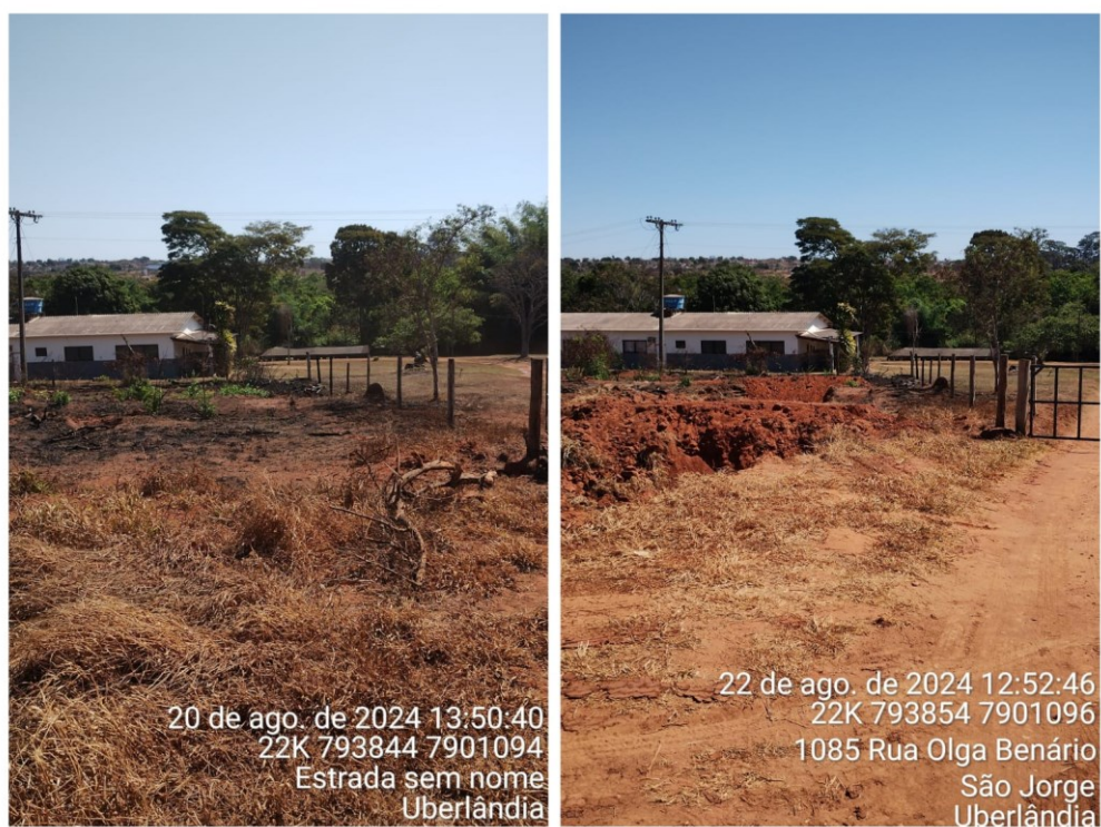
Figura 12: Comparativo do solo antes e depois da construção das curvas em nível.
